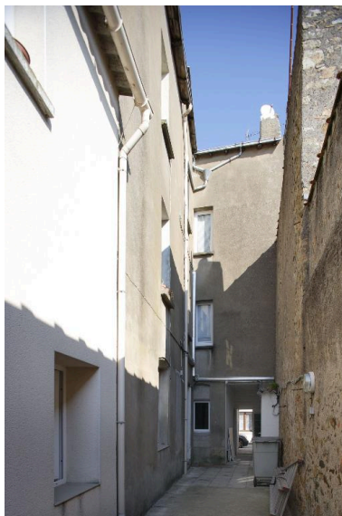
La maison vue depuis la cour vers la rue. Phot. François Lasa IVR52_20054401367NUCA
