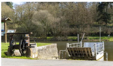
La barge et le treuil. Phot. Pierre-Bernard Fourny IVR52_20225300264NUCA
