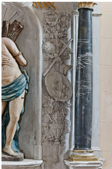
Vue de détail du retable de sainte Anne : chute d'objets de culte accostant la niche à droite. Phot. Yves Guillotin IVR52_20125300296NUCA
