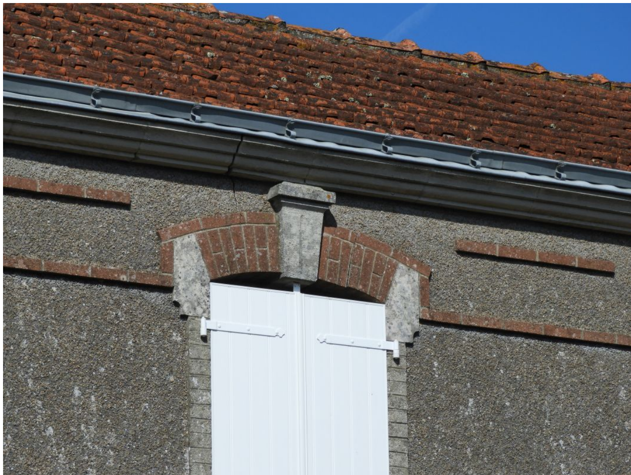
Détail du décor en brique de la façade : bandeaux, linteau.
