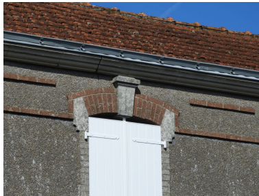
Détail du décor en brique de la façade : bandeaux, linteau. Phot. Yannis Suire IVR52_20198500407NUCA
