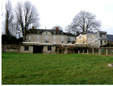
Façade donnant sur la Sarthe. Phot. Bruno Rousseau IVR52_20074900269NUCA
