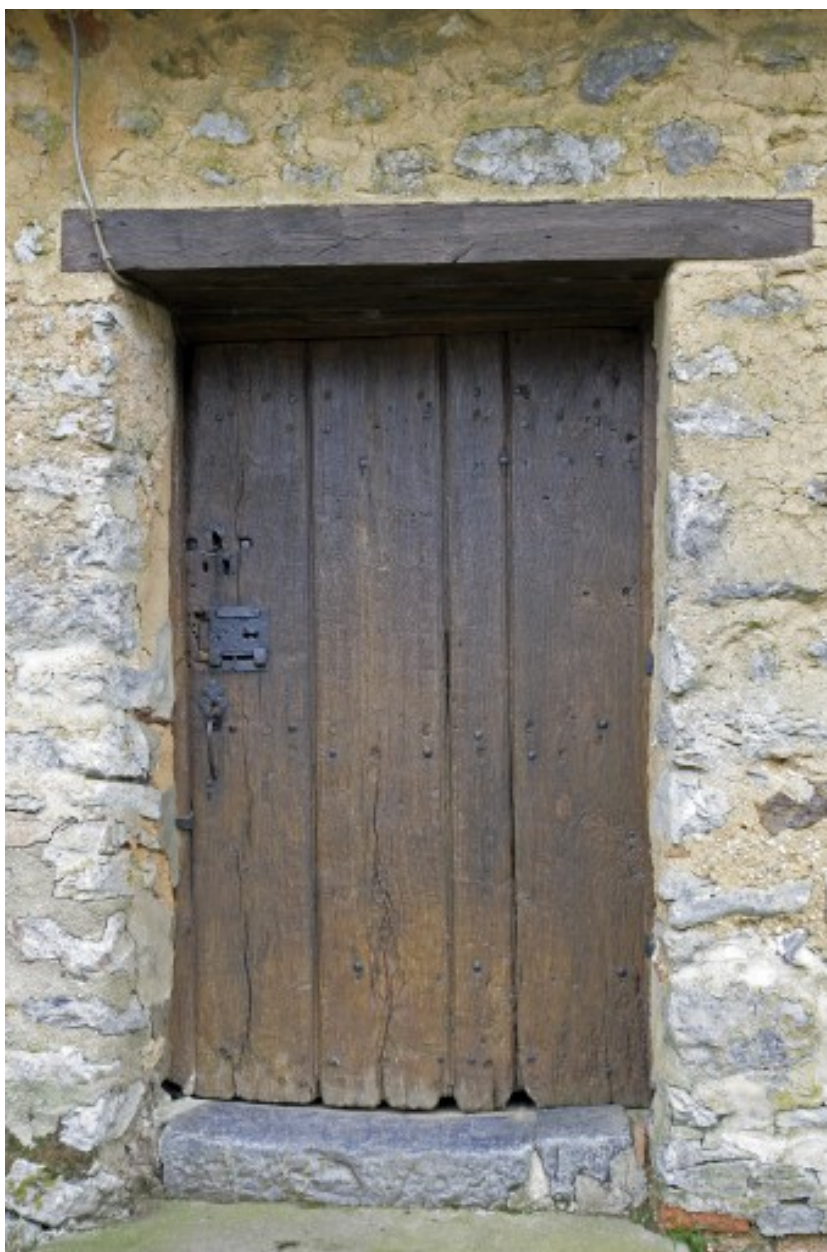
L'ancien logis-étable : la porte vue depuis l'extérieur.
