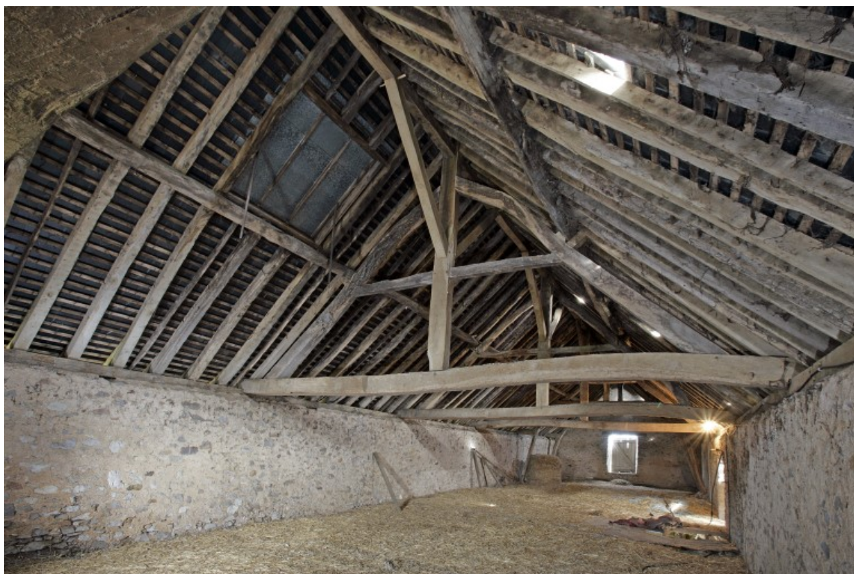
L'étable : la charpente vue depuis le sud-ouest.
