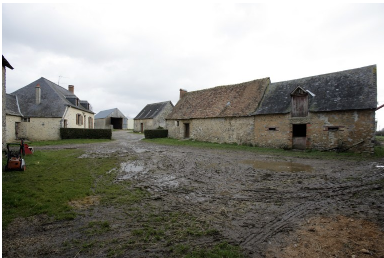
Vue d'ensemble depuis la cour à l'ouest. De gauche à droite : le logis, la remise, l'écurie et l'ancien logis-étable.
