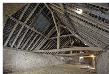
L'étable : la charpente vue depuis le sud-ouest. Phot. François Lasa IVR52_20075301420NUCA
