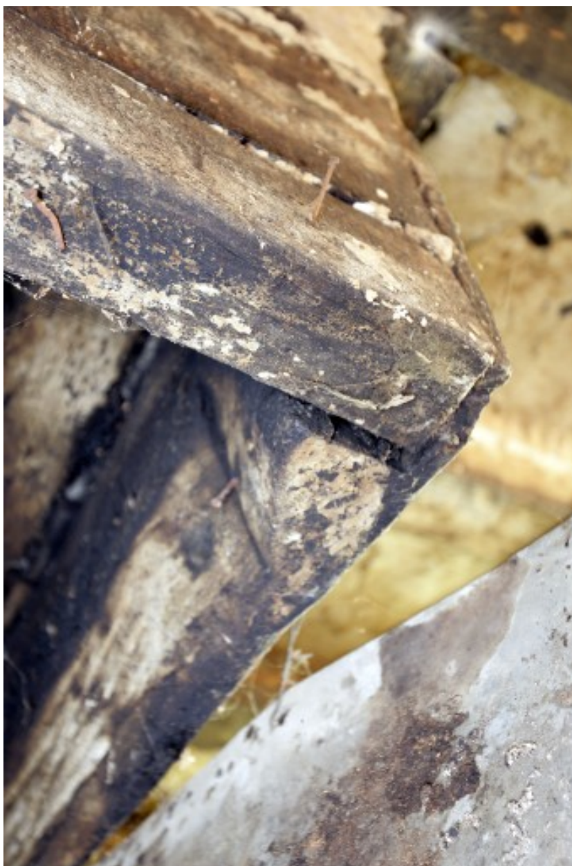
L'ancien logis-étable : détail d'assemblage du manteau de la cheminée.
