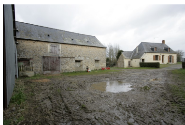
L'étable et le logis vus depuis la cour au sud. Phot. François Lasa IVR52_20075301415NUCA
