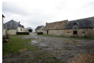
Vue d'ensemble depuis la cour à l'ouest. De gauche à droite : le logis, la remise, l'écurie et l'ancien logis-étable. Phot. François Lasa IVR52_20075301416NUCA
