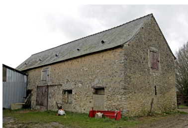
L'étable vue depuis la cour à l'est. Phot. François Lasa IVR52_20075301418NUCA
