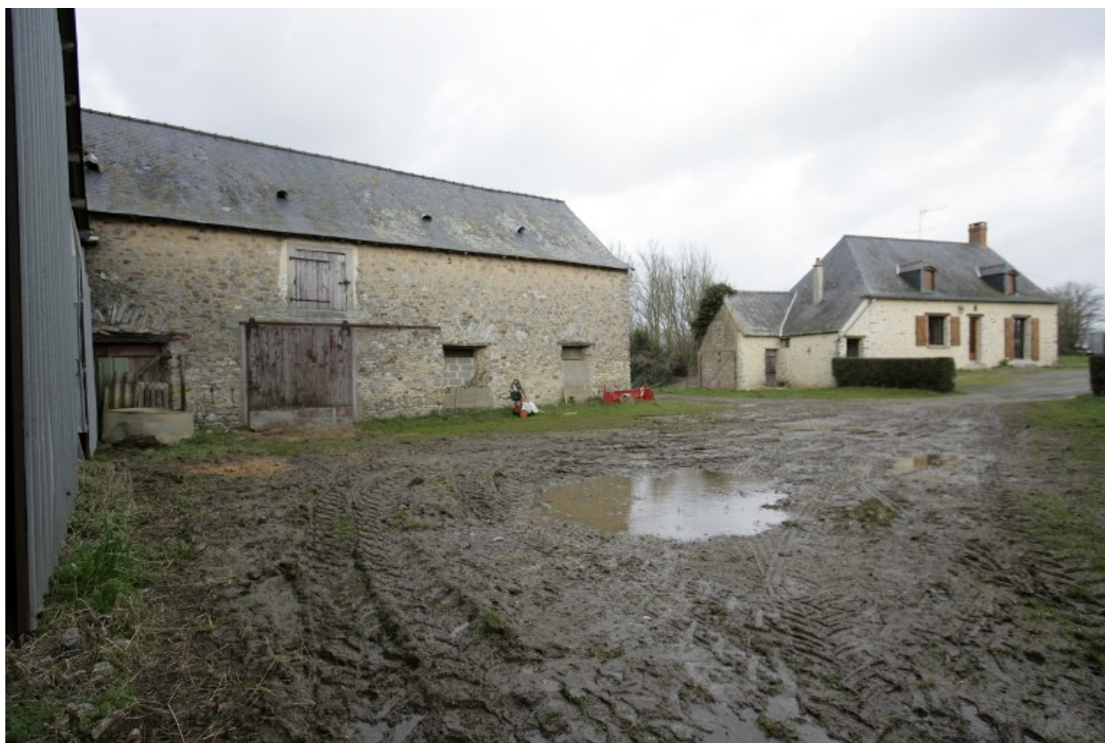
L'étable et le logis vus depuis la cour au sud.
