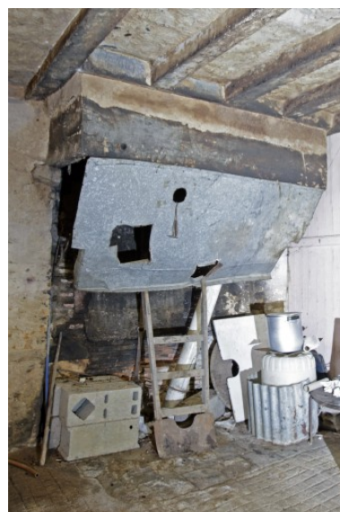
L'ancien logis-étable : la cheminée. Phot. François Lasa IVR52_20075301424NUCA
