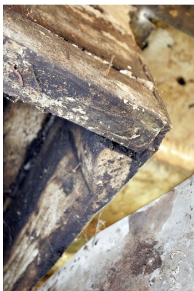
L'ancien logis-étable : détail d'assemblage du manteau de la cheminée. Phot. François Lasa IVR52_20075301425NUCA
