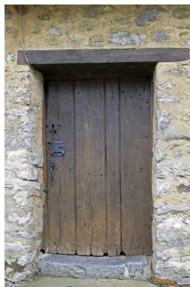
L'ancien logis-étable : la porte vue depuis l'extérieur. Phot. François Lasa IVR52_20075301421NUCA
