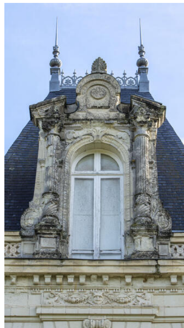
La grande lucarne centrale de l'élévation antérieure. Phot. Pierre-Bernard Fourny IVR52_20235301706NUCA
