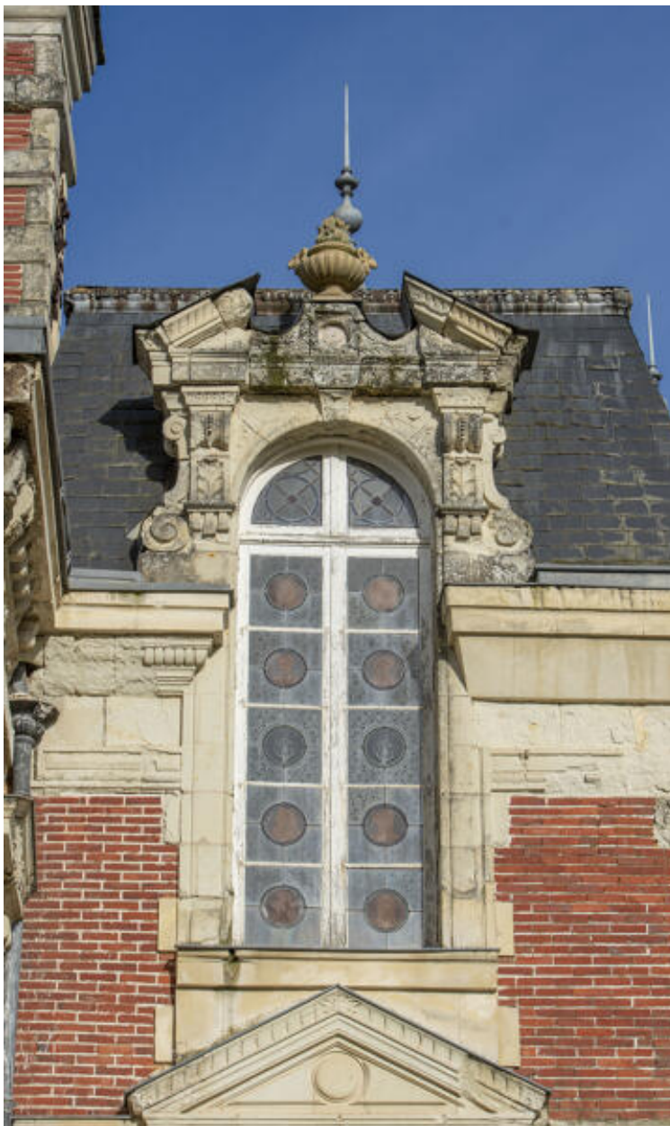
La cage d'escalier, détail d'une fenêtre.
