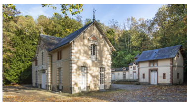
Les deux bâtiments des écuries-remises. Phot. Pierre-Bernard Fourny IVR52_20235301721NUCA
