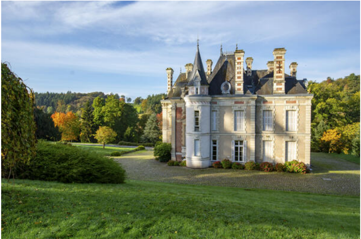
L'élévation postérieure vers le coteau.
