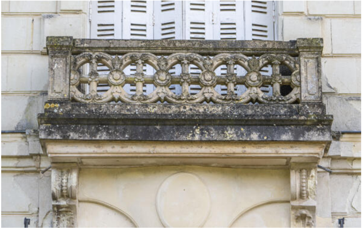
Le balcon au centre de l'élévation antérieure.
