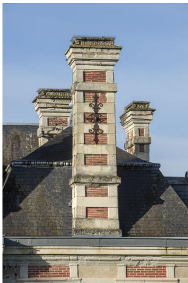
Les souches de cheminées. Phot. Pierre-Bernard Fourny IVR52_20235301766NUCA
