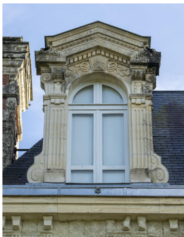
Une lucarne de l'élévation antérieure. Phot. Pierre-Bernard Fourny IVR52_20235301709NUCA
