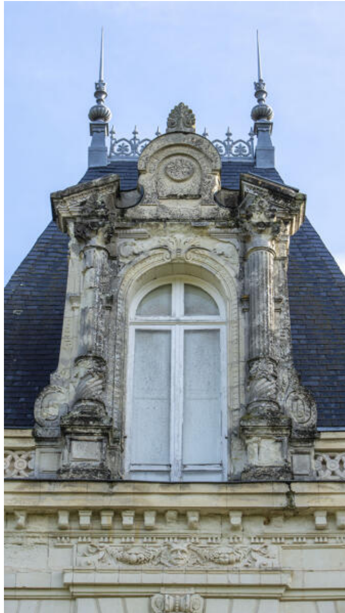
La grande lucarne centrale de l'élévation antérieure.
