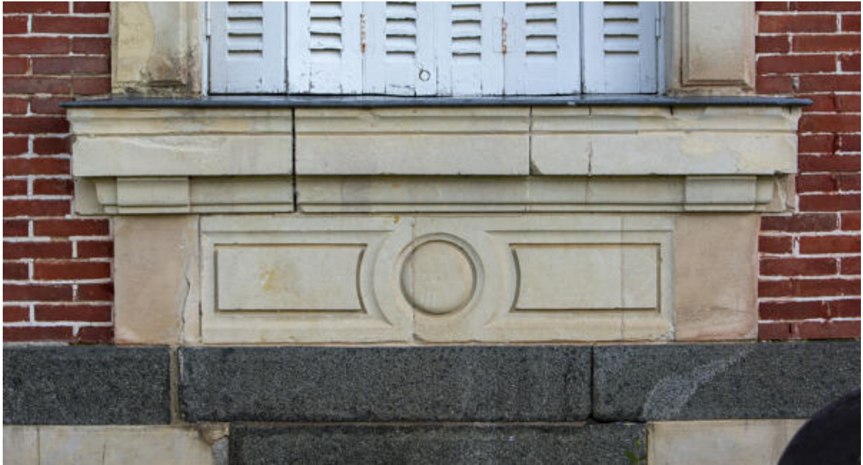
Une allège de fenêtre de l'élévation antérieure.
