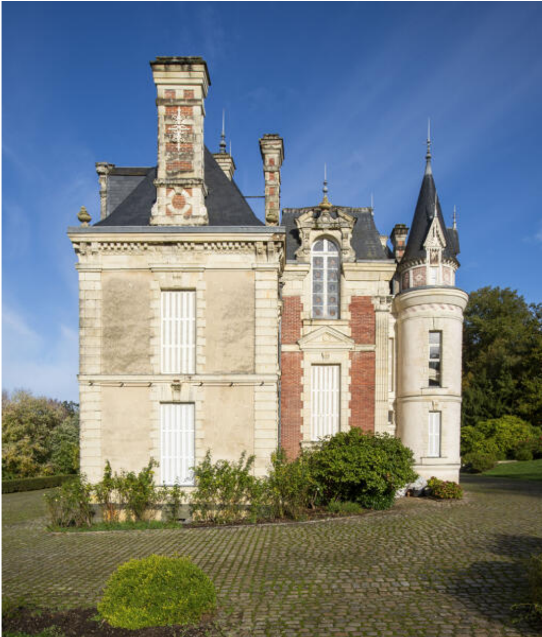
L'élévation latérale sud.
