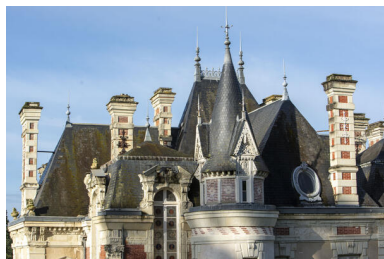
Une vue des toits. Phot. Pierre-Bernard Fourny IVR52_20235301762NUCA
