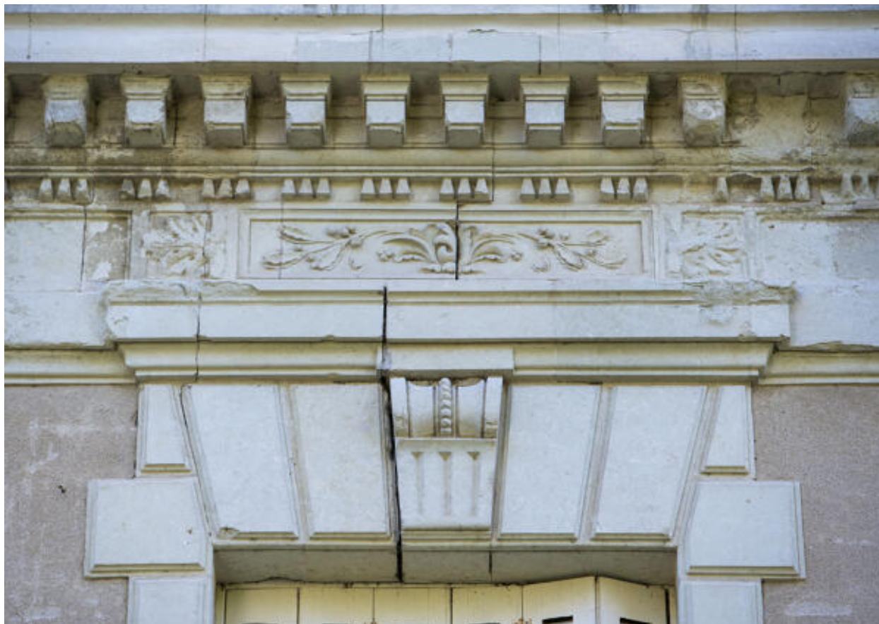
Un linteau, une agrafe et la corniche de l'élévation latérale nord.
