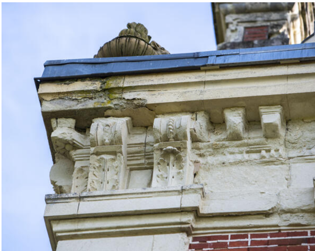
Un détail de la corniche à modillons.
