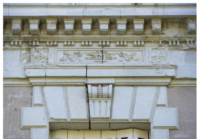
Un linteau, une agrafe et la corniche de l'élévation latérale nord. Phot. Pierre-Bernard Fourny IVR52_20235301713NUCA
