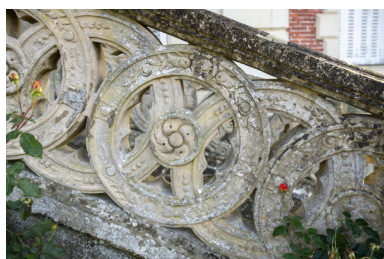
Le perron, détail. Phot. Pierre-Bernard Fourny IVR52_20235301695NUCA
