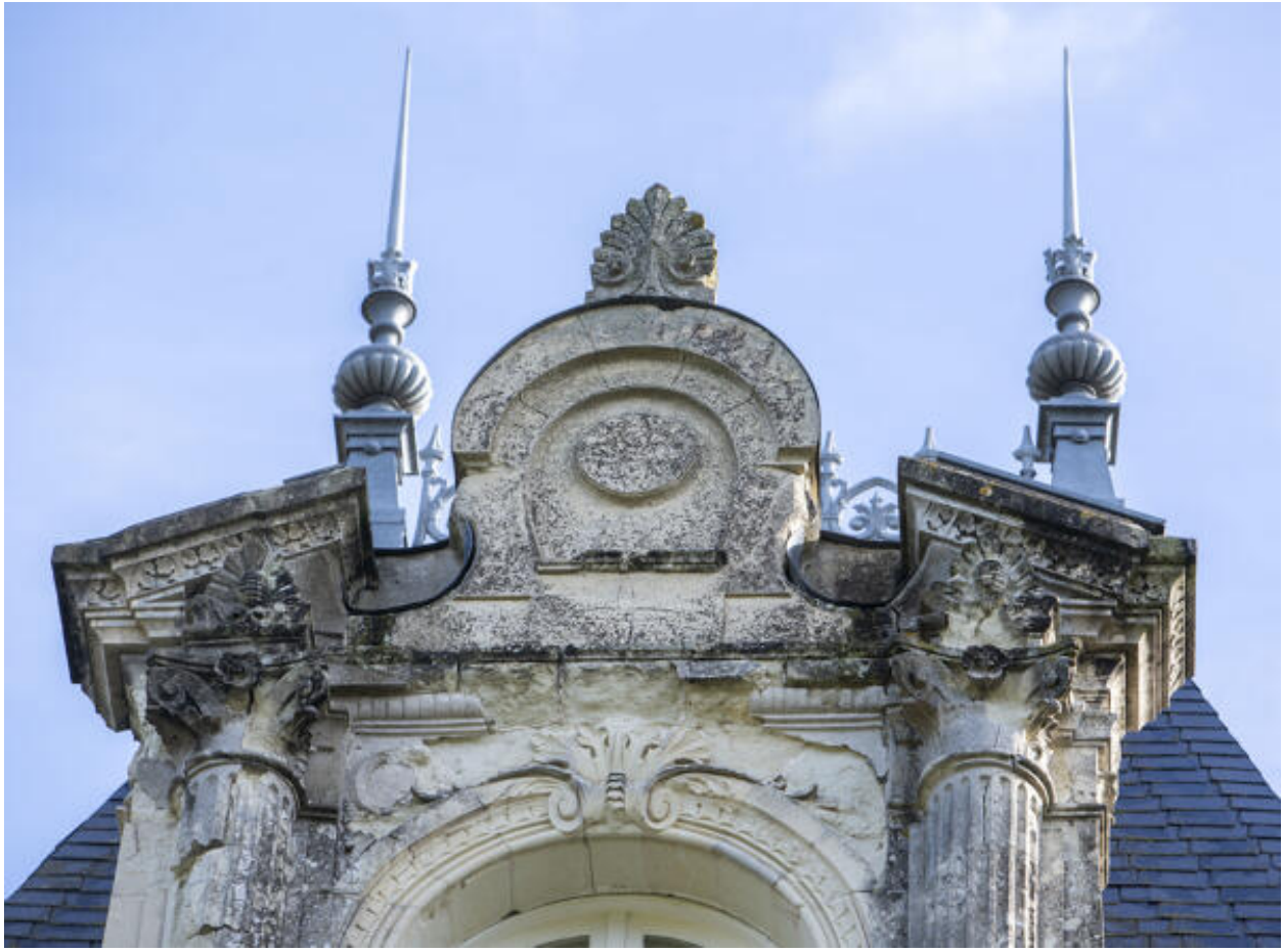
La grande lucarne centrale de l'élévation antérieure, détail.
