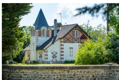
Le logement du gardien. Phot. Pierre-Bernard Fourny IVR52_20235301325NUCA
