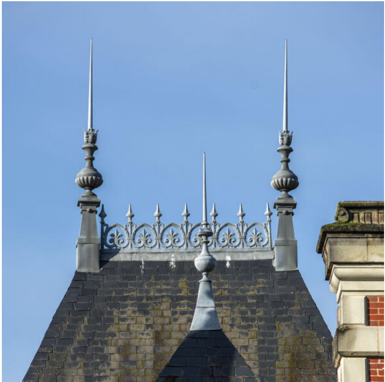
Le sommet du toit du pavillon axial.
