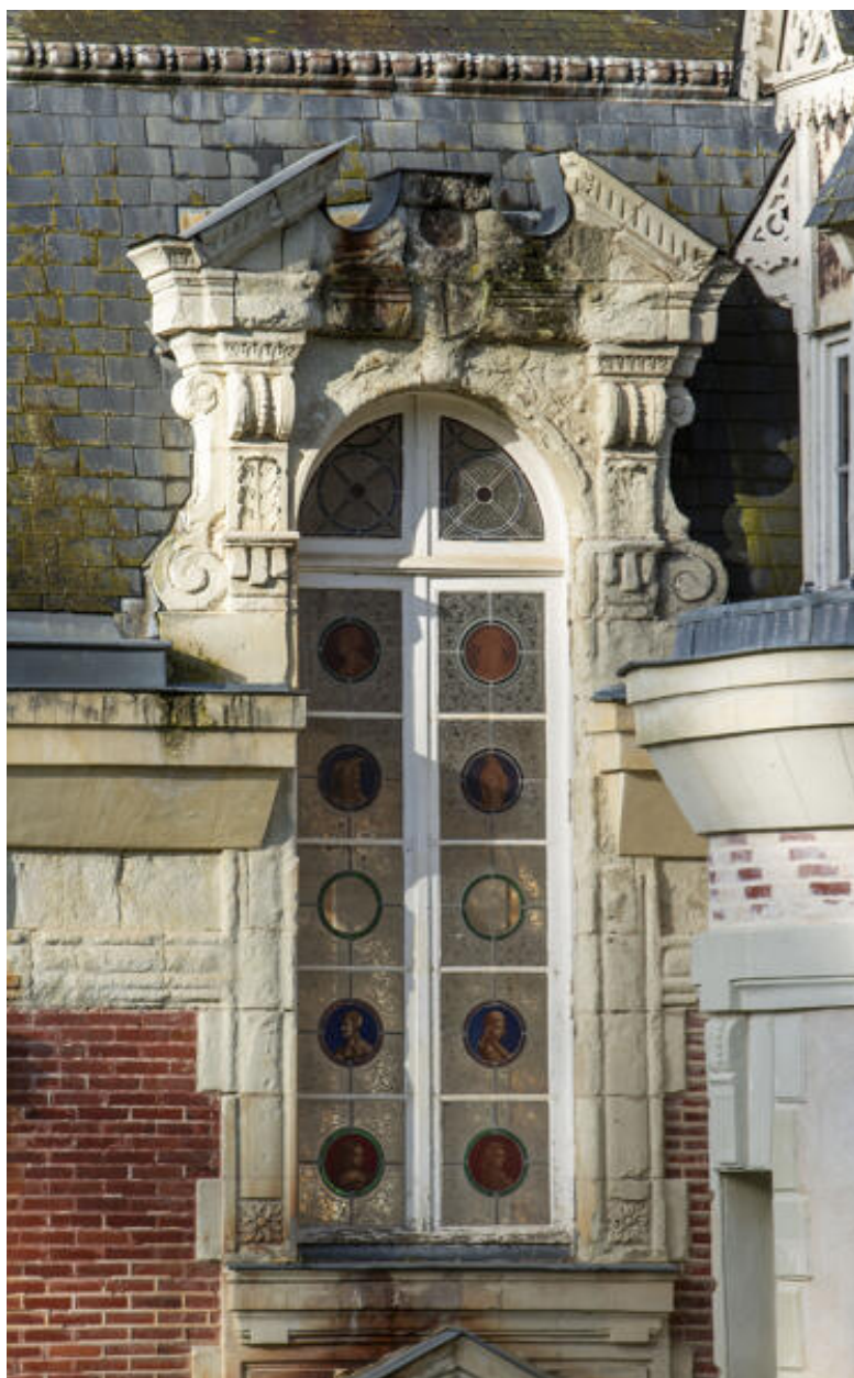
Le cage d'escalier, détail d'une fenêtre.
