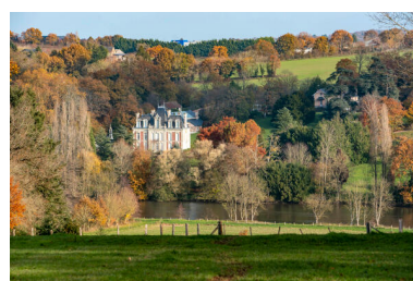
Une vue d'ensemble depuis le coteau opposé. Phot. Pierre-Bernard Fourny IVR52_20225301202NUCA
