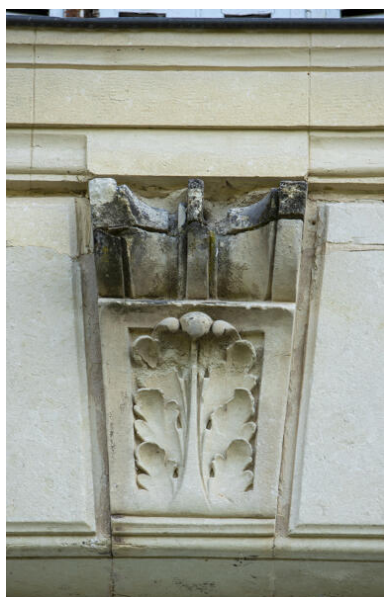
Une agrafe sculptée de l'élévation antérieure. Phot. Pierre-Bernard Fourny IVR52_20235301712NUCA
