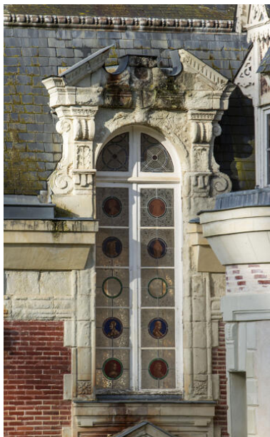
Le cage d'escalier, détail d'une fenêtre. Phot. Pierre-Bernard Fourny IVR52_20235301764NUCA
