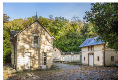
Les deux bâtiments des écuries-remises. Phot. Pierre-Bernard Fourny IVR52_20235301736NUCA
