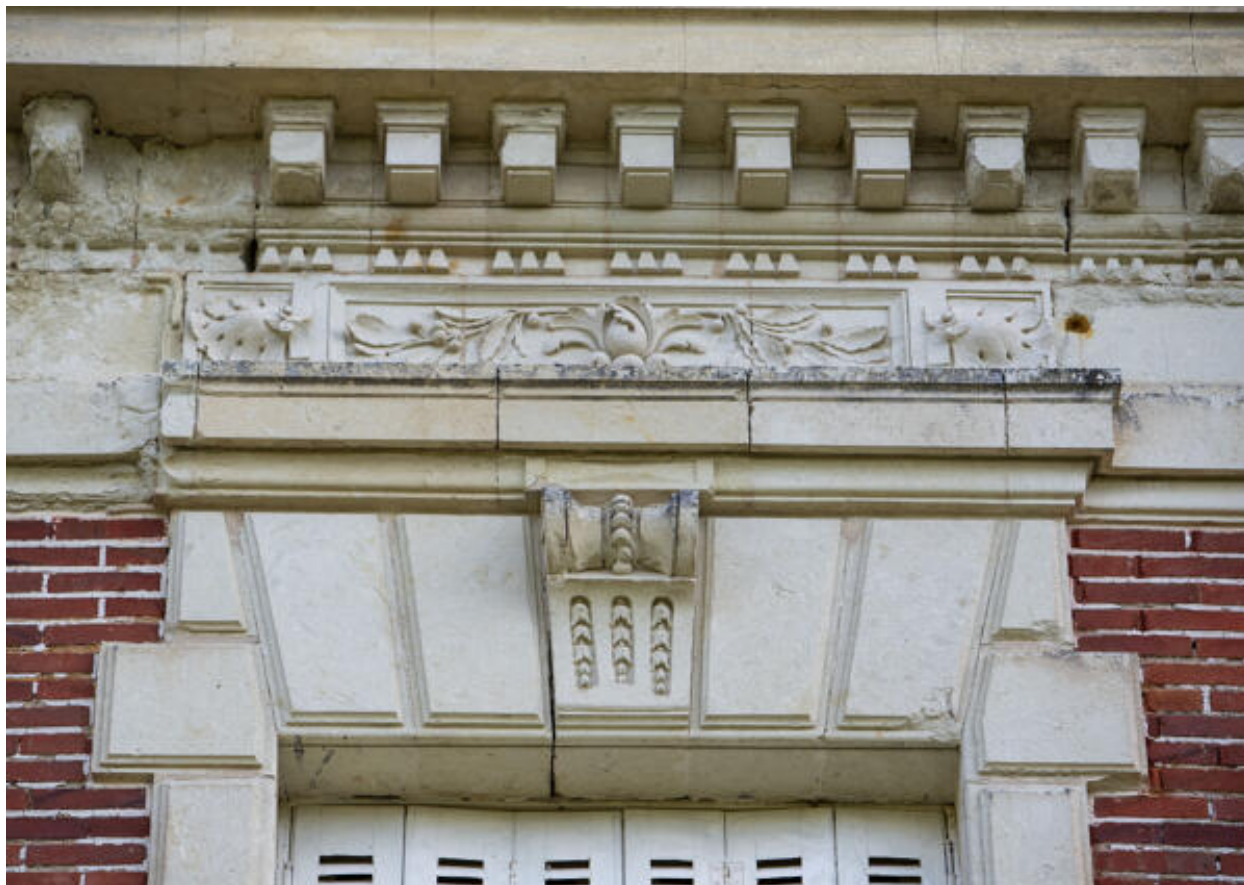
Un détail d'un linteau, d'une agrafe et de la corniche de l'élévation antérieure.
