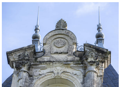
La grande lucarne centrale de l'élévation antérieure, détail. Phot. Pierre-Bernard Fourny IVR52_20235301704NUCA
