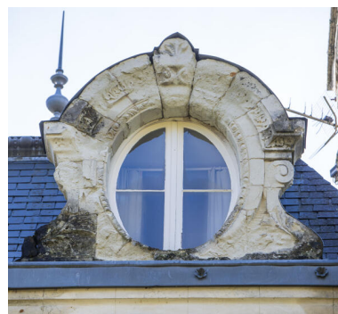
Un oeil-de-boeuf de l'élévation latérale nord. Phot. Pierre-Bernard Fourny IVR52_20235301714NUCA
