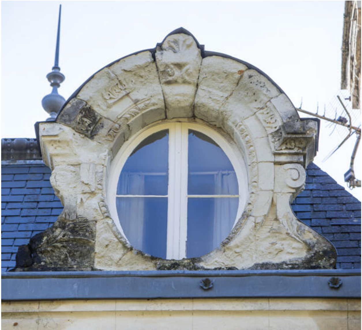
Un oeil-de-boeuf de l'élévation latérale nord.
