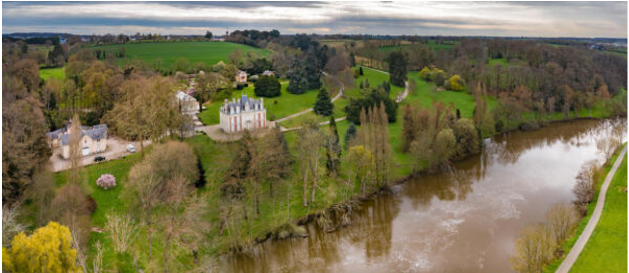
Une vue aérienne du site.
