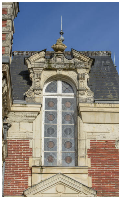
La cage d'escalier, détail d'une fenêtre. Phot. Pierre-Bernard Fourny IVR52_20235301700NUCA
