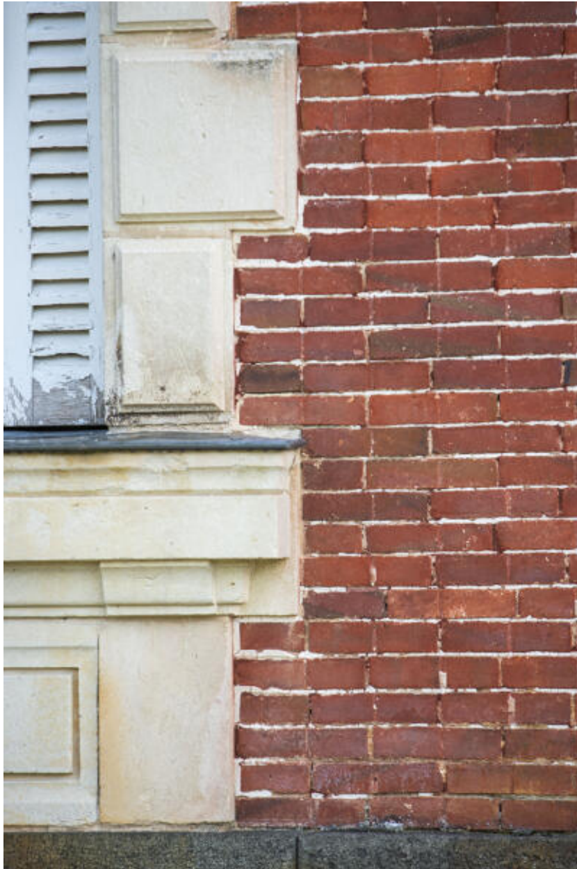
Un détail de la maçonnerie de l'élévation antérieure.
