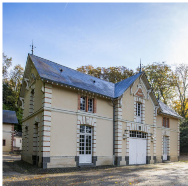
La seconde écurie-remise. Phot. Pierre-Bernard Fourny IVR52_20235301723NUCA
