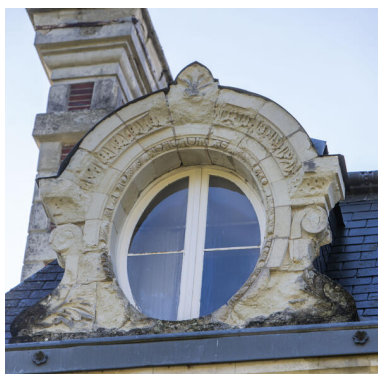
Un oeil-de-boeuf de l'élévation latérale nord. Phot. Pierre-Bernard Fourny IVR52_20235301715NUCA
