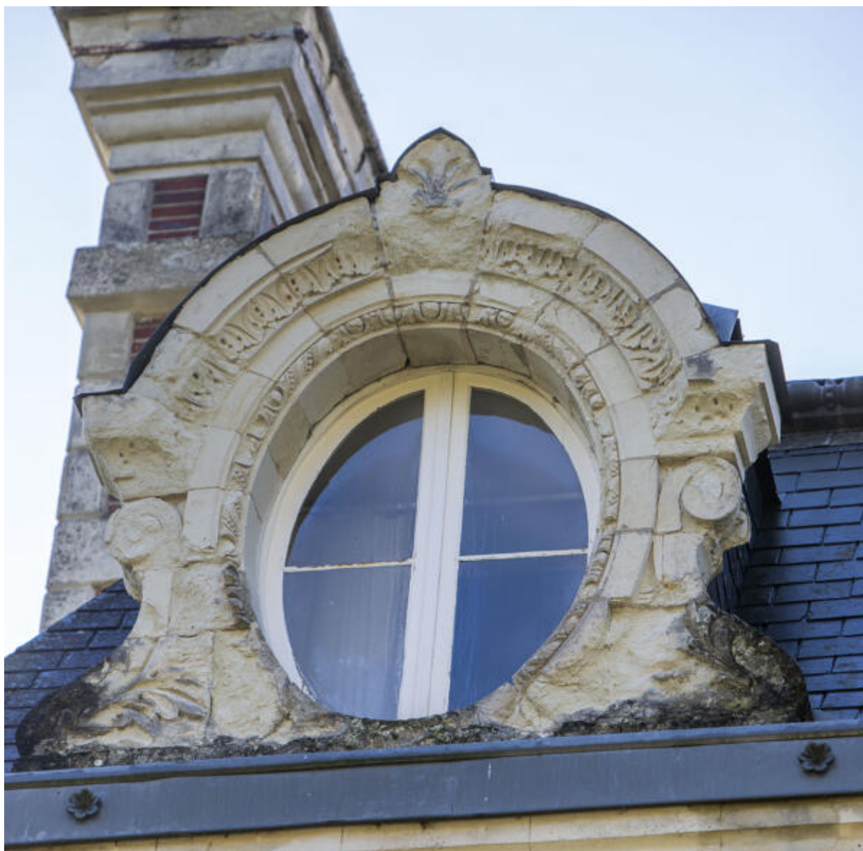
Un oeil-de-boeuf de l'élévation latérale nord.
