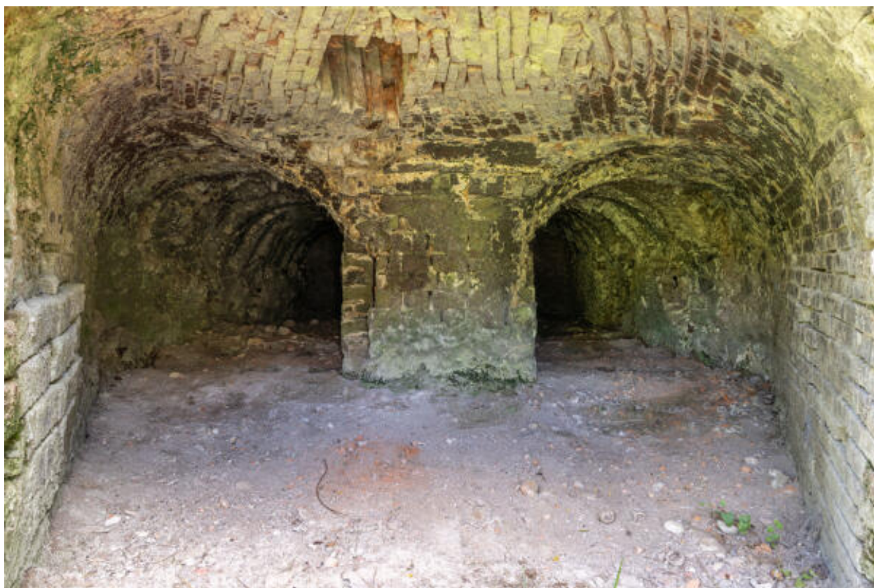
Le four : intérieur de l'alandier.
