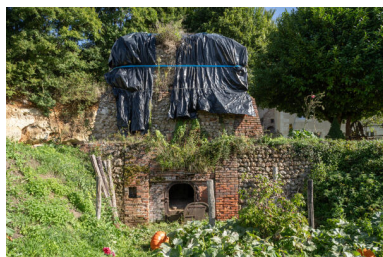
Le four, vue depuis le sud. Phot. Jeanne Minier IVR52_20257200531NUCA
