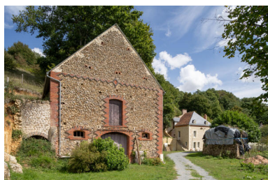
Vue d'ensemble depuis l'entrée du site. Phot. Jeanne Minier IVR52_20257200523NUCA
