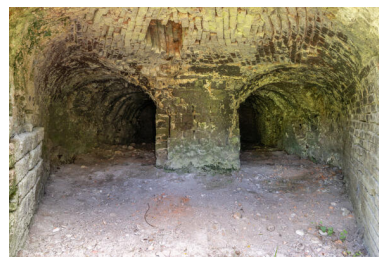
Le four : intérieur de l'alandier. Phot. Jeanne Minier IVR52_20257200533NUCA
