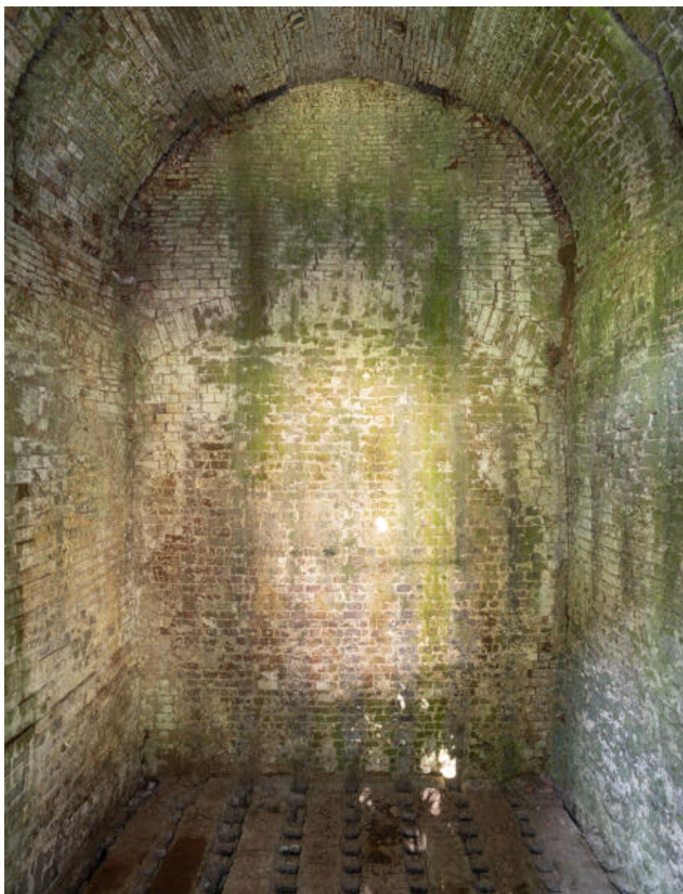
Le four : intérieur de la chambre de cuisson.
