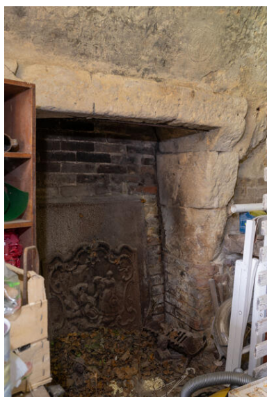
Habitat troglodytique : cheminée. Phot. Jeanne Minier IVR52_20257200542NUCA
