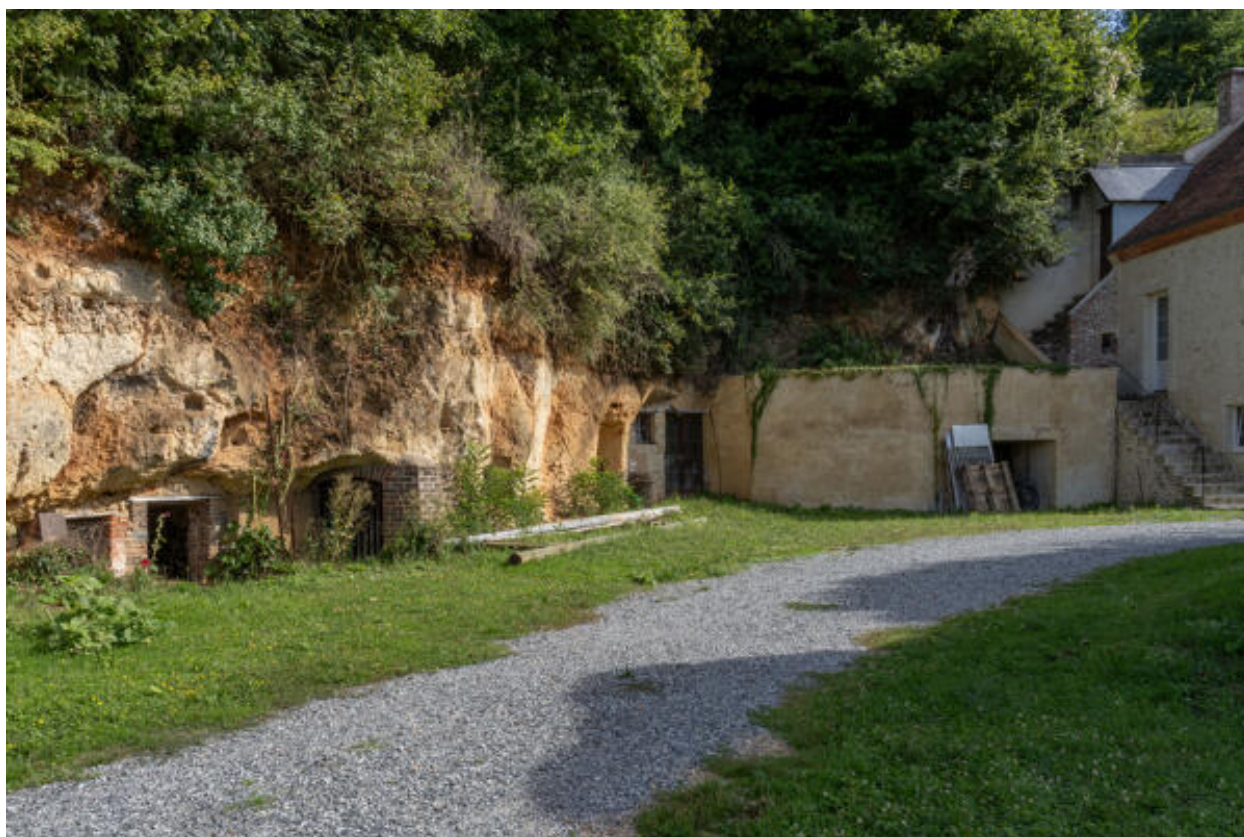
Entrées des aménagements troglodytiques dans le coteau.
