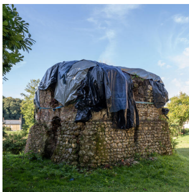
Le four, vue de biais. Phot. Jeanne Minier IVR52_20257200528NUCA
