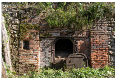
Le four : bouche de l'alandier, côté sud. Phot. Jeanne Minier IVR52_20257200532NUCA
