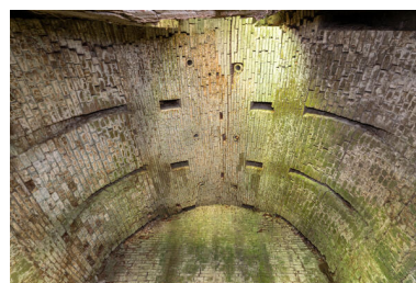
Le four : intérieur de la chambre de cuisson, voûte et événements. Phot. Jeanne Minier IVR52_20257200536NUCA
