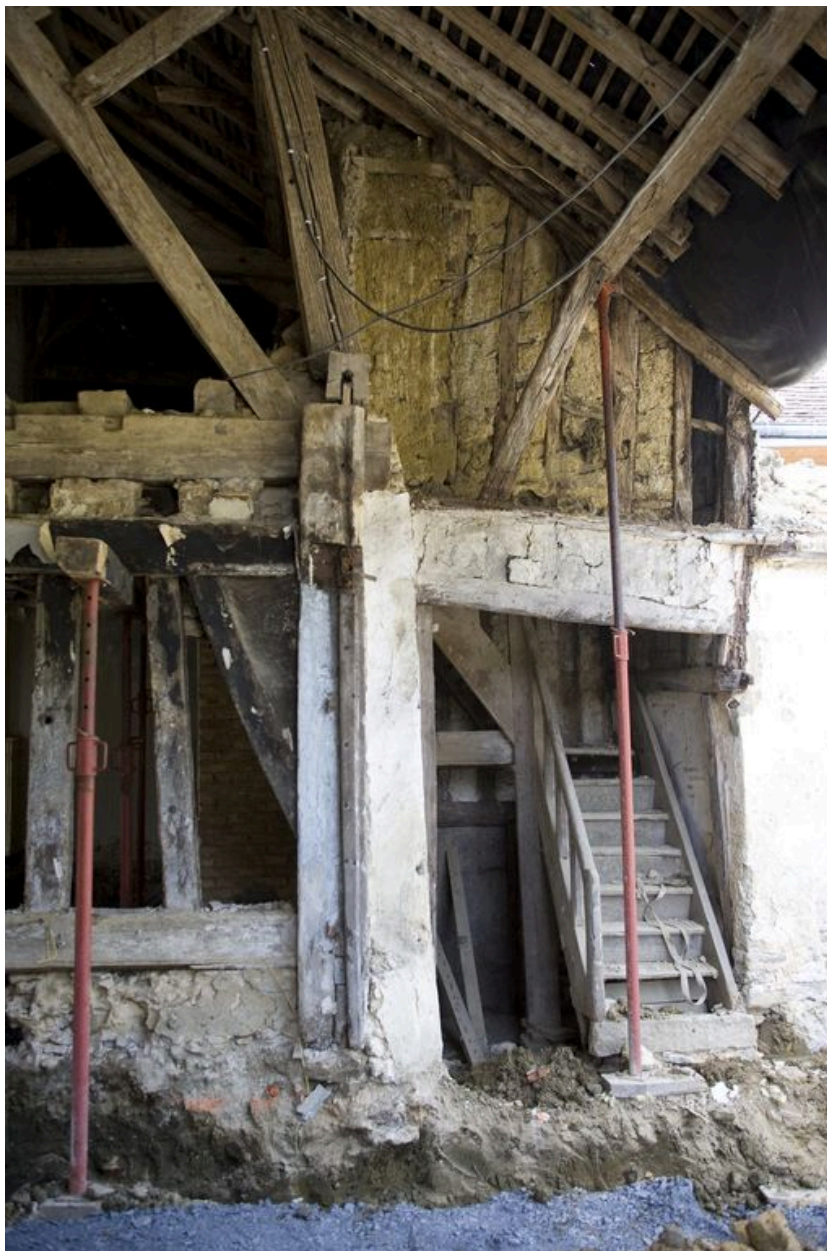
Logis, coupe du mur nord. A droite, la tour d'escalier, à gauche, le mur de refend entre la cuisine et la salle.
