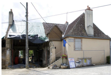
Ensemble depuis le nord-est. Phot. François Lasa IVR52_20087201347NUCA
