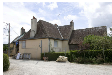
Ensemble depuis le nord. Phot. François Lasa IVR52_20087201346NUCA
