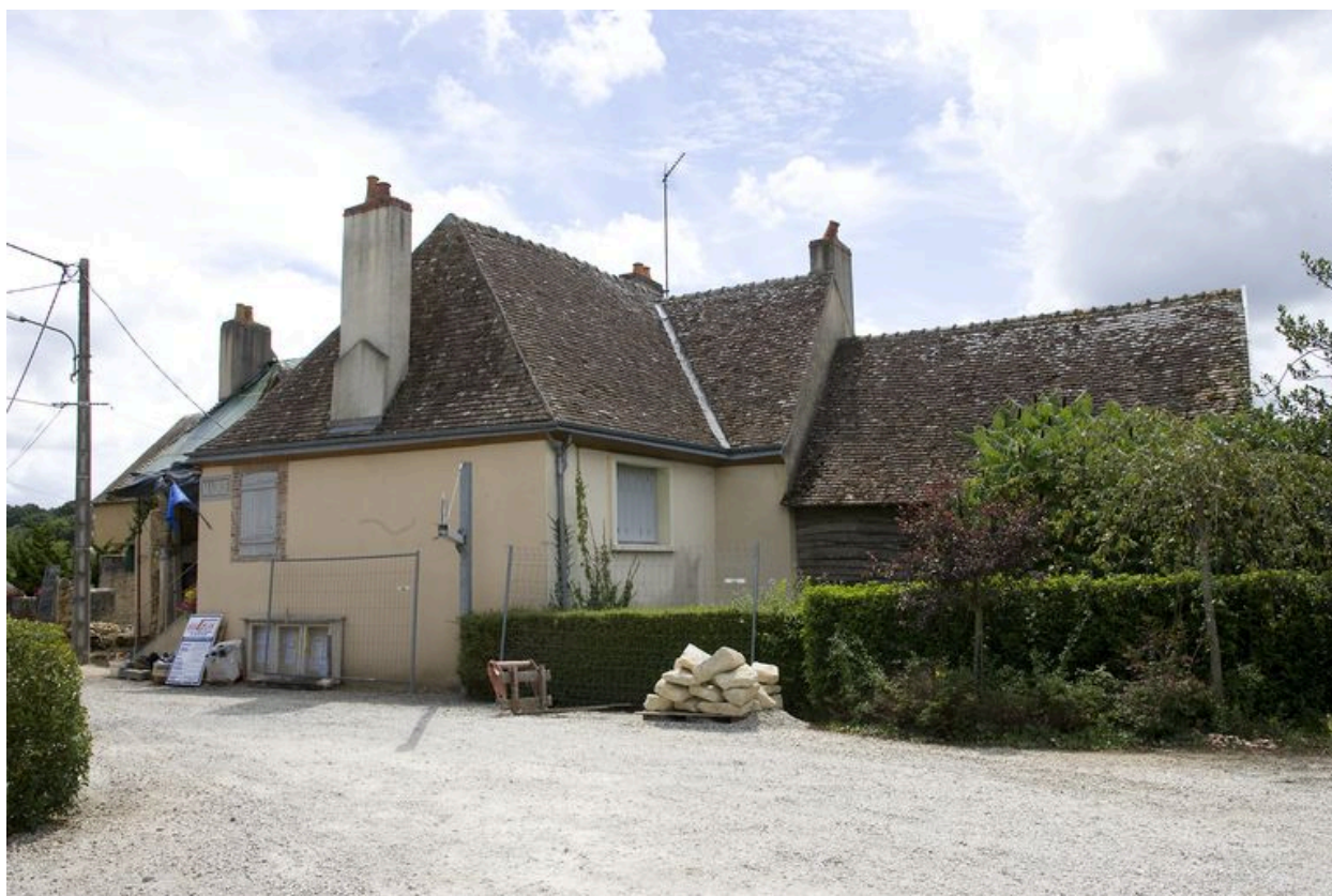
Ensemble depuis le nord.
