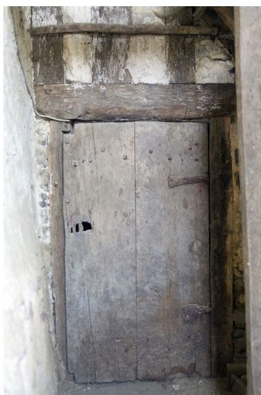
Tour d'escalier : porte vers la cave. Phot. François Lasa IVR52_20087201344NUCA
