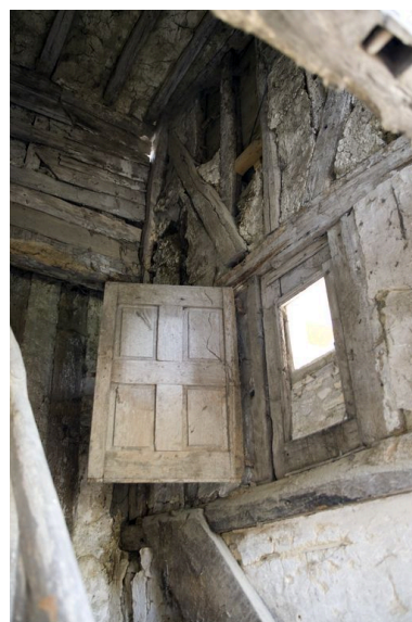
Fenêtre de la tour d'escalier. Phot. François Lasa IVR52_20087201345NUCA
