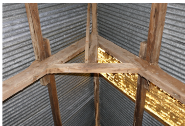
Détail de l'une des fermes de la charpente. Phot. Denis Pillet IVR52_20084400609NUCA
