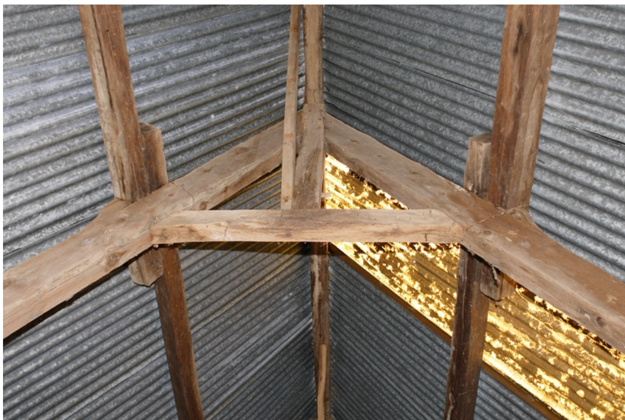
Détail de l'une des fermes de la charpente.
