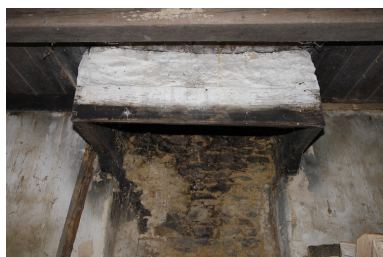
Détail de la cheminée du 1er logis. Phot. Denis Pillet IVR52_20084400604NUCA
