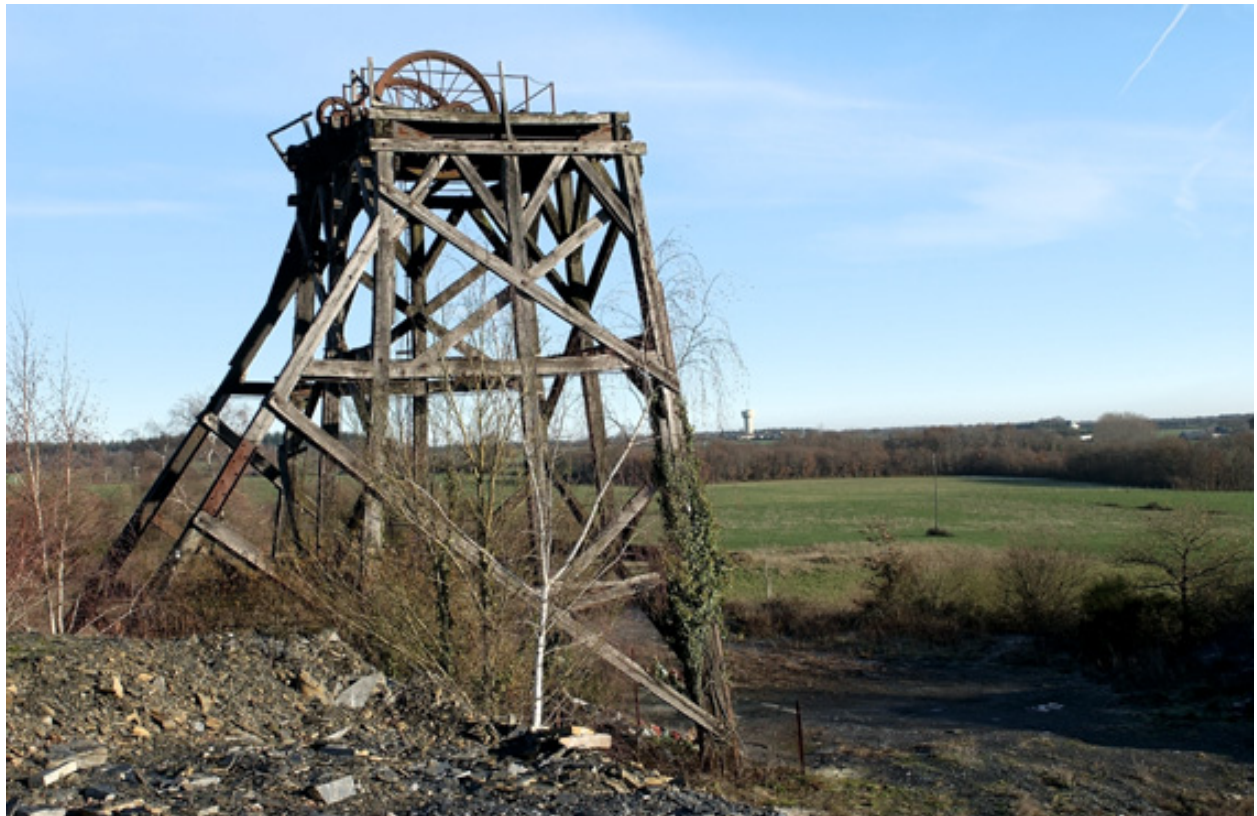
Chevalement en bois de La Pouëze, Maine-et-Loire.
