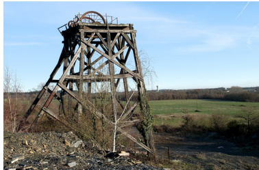
Chevalement en bois de La Pouëze, Maine-et-Loire. Phot. Bruno Rousseau IVR52_20044900057NUCA
