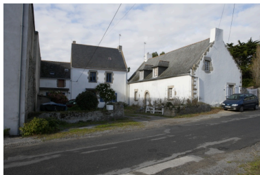
Vue d'ensemble depuis l'est. Phot. Denis Pillet IVR52_20074401657NUCA
