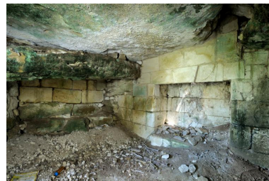
Aménagements du XIXe siècle (cheminée, murs) sous les dalles effondrées du dolmen. Phot. Bruno Rousseau, Phot. Youenn Communeau IVR52_20124901312NUCA
