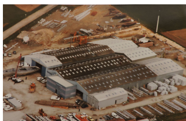
Vue aérienne du chantier naval depuis le sud vers 1980. Phot. Yannis (reproduction) Suire IVR52_20218501193NUCA
