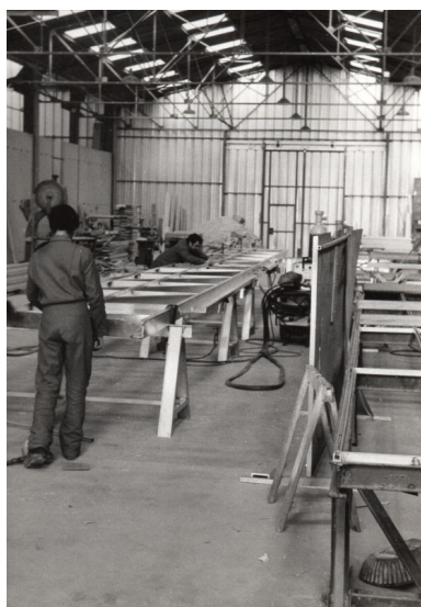
Fabrication de pontons Vers 1980. Phot. Yannis (reproduction) Suire IVR52_20198503735NUCA
