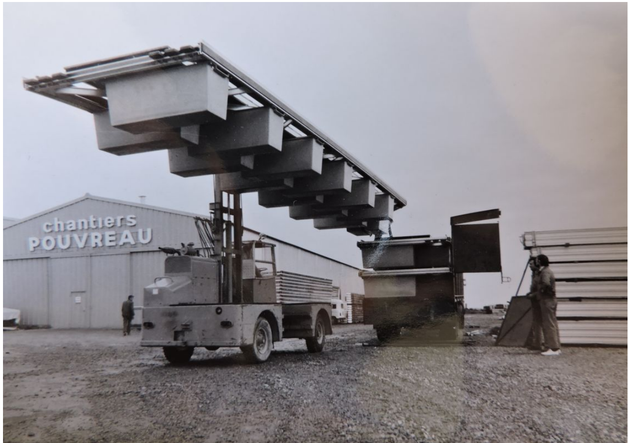
Pontons sortis du chantier naval, vers 1980.
