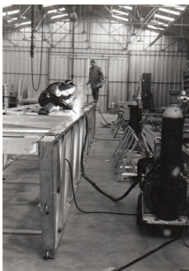
Fabrication de pontons vers 1980. Phot. Yannis (reproduction) Suire IVR52_20198503752NUCA
