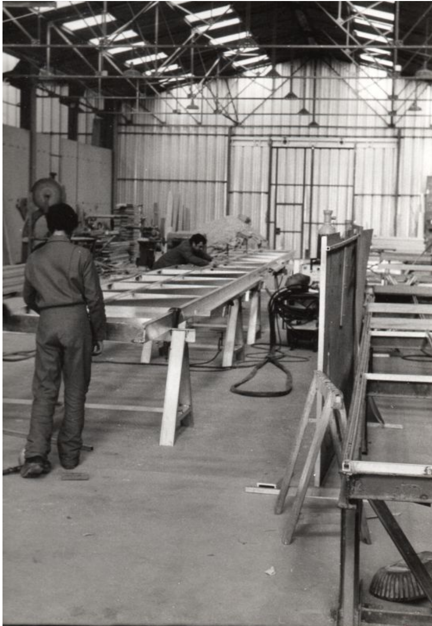
Fabrication de pontons Vers 1980.
