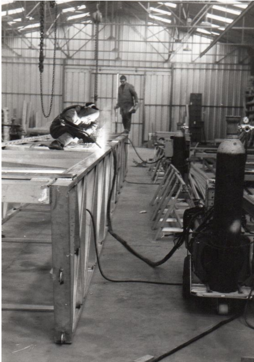
Fabrication de pontons vers 1980.
