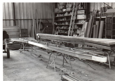
Fabrication de pontons vers 1980. Phot. Yannis (reproduction) Suire IVR52_20198503749NUCA
