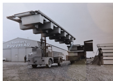
Pontons sortis du chantier naval, vers 1980. Phot. Yannis (reproduction) Suire IVR52_20198502780NUCA
