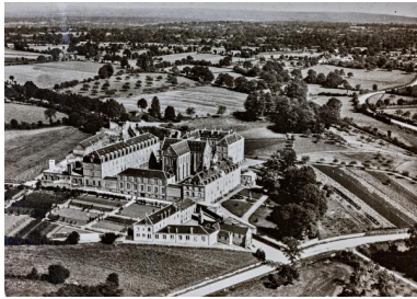
Vue aérienne de la communauté Saint-Fraimbault de Lassay. Repro. Yves Guillotin IVR52_20205300187NUCA
