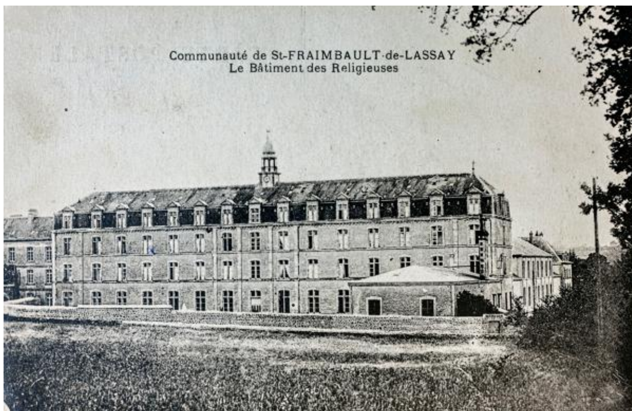
Le bâtiment des religieuses vu du nord.
