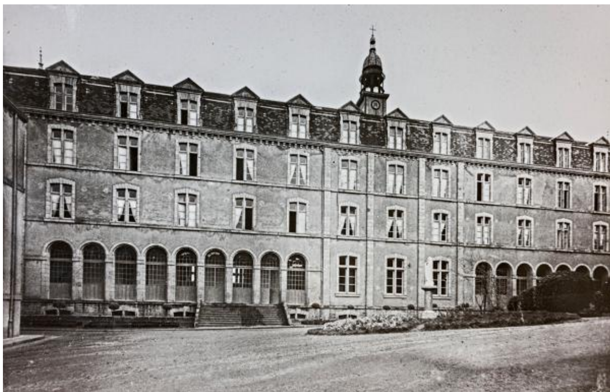
Maison conventuelle des soeurs (bâtiment A).
