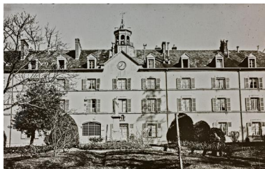
Face sud de l'actuel bâtiment C. Repro. Yves Guillotin IVR52_20205300193NUCA
