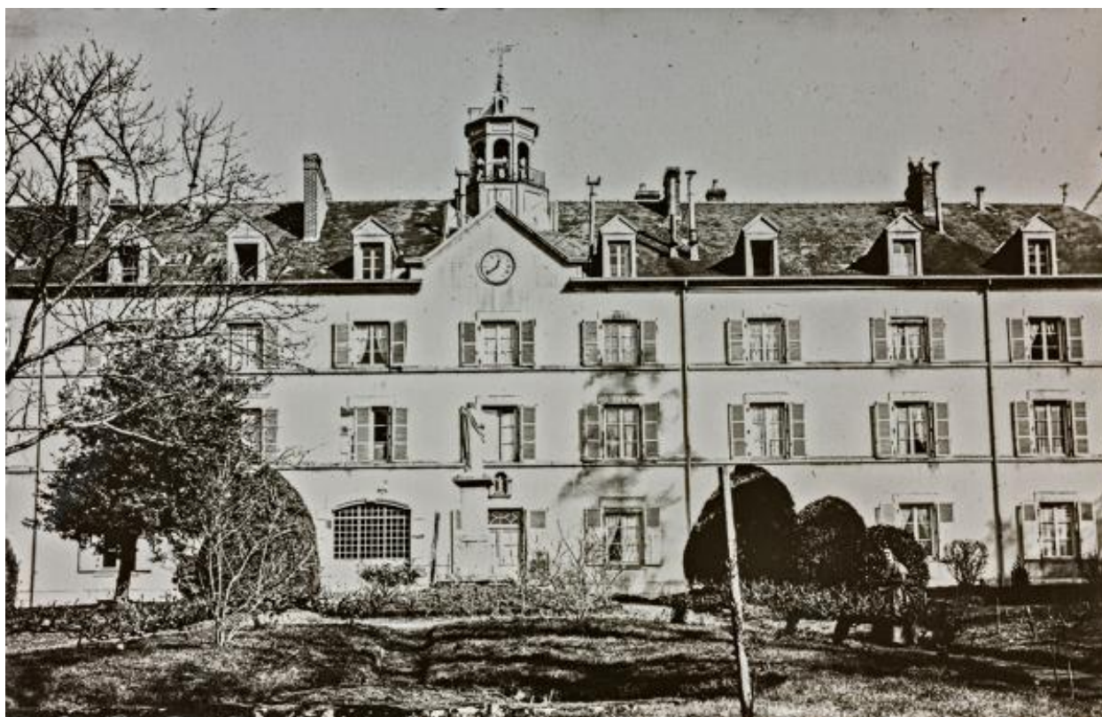
Face sud de l'actuel bâtiment C.
