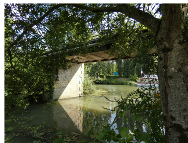
Le pont vu en amont, depuis le nord-ouest. Phot. Yannis Suire IVR52_20228500084NUCA
