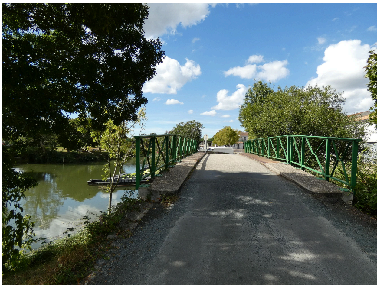
Le pont vu depuis l'est.
