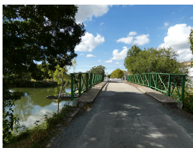
Le pont vu depuis l'est. Phot. Yannis Suire IVR52_20228500258NUCA
