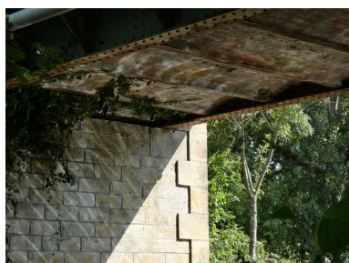
Détail : culée en maçonnerie de pierre, tablier en métal et brique. Phot. Yannis Suire IVR52_20228500085NUCA
