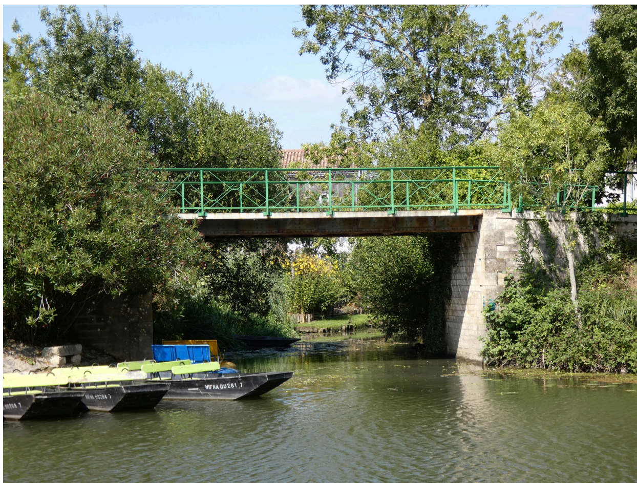
Le pont vu depuis le sud.
