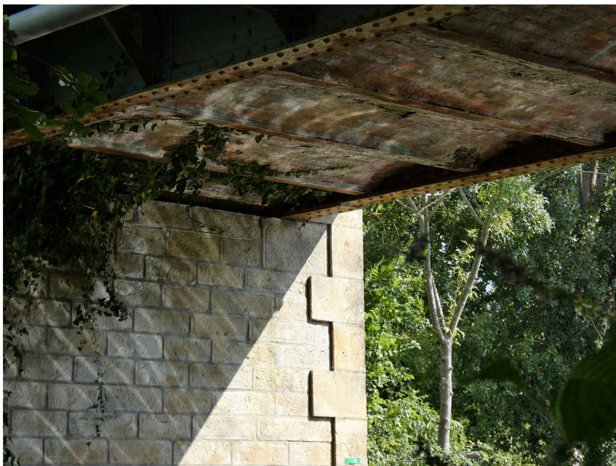
Détail : culée en maçonnerie de pierre, tablier en métal et brique.
