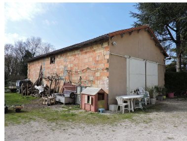
L'ancien atelier de maçon vu depuis le nord-est.
