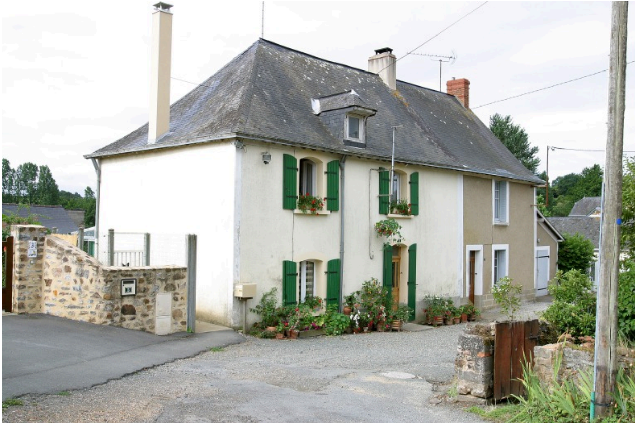
Façade sur rue (partie droite).
