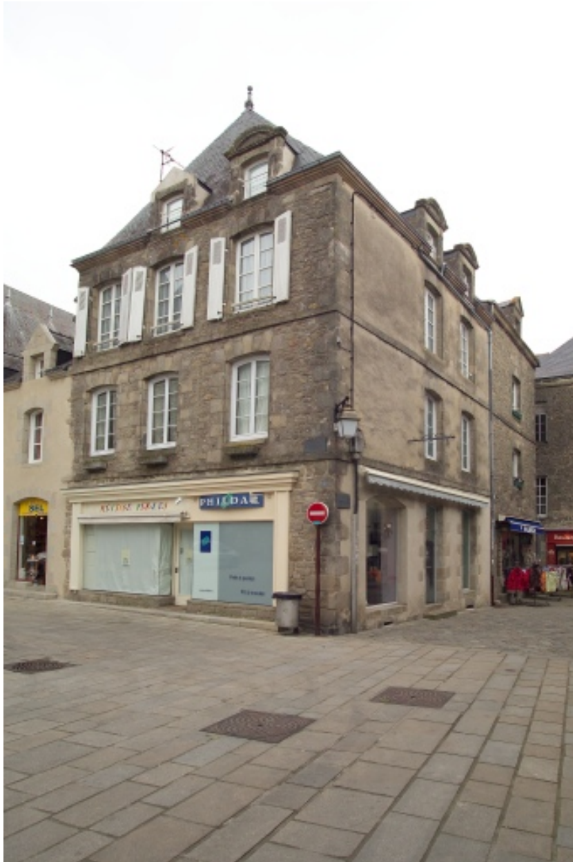
Vue générale vers le Nord-Est.
