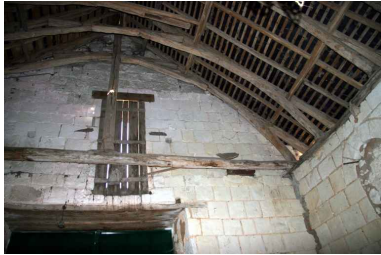
Charpente de la chapelle : ferme principale. Phot. Jean-Baptiste Darrasse IVR52_20067206015NUCA
