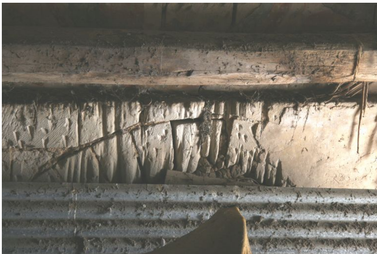
Arc diaphragme côté nef : la trace des cordes des cloches.
