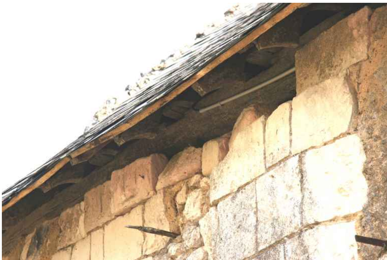
Mur droit de la nef, détail : coyaux.
