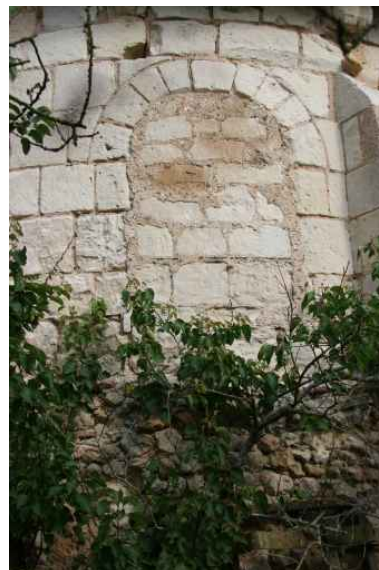
L'abside : baie en plein cintre obstruée. Phot. Jean-Baptiste Darrasse IVR52_20067206007NUCA
