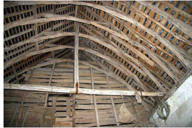
La chapelle : charpente à chevrons-portant-fermes de la nef et cloison de division. Phot. Jean-Baptiste Darrasse IVR52_20067206011NUCA
