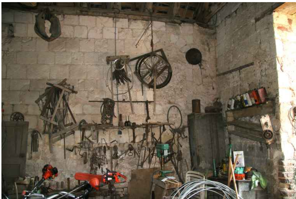
Mur droit de la nef : baie plein cintre obstruée.
