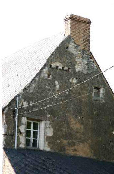
La maison du prieur : pignon. Phot. Jean-Baptiste Darrasse IVR52_20067206029NUCA
