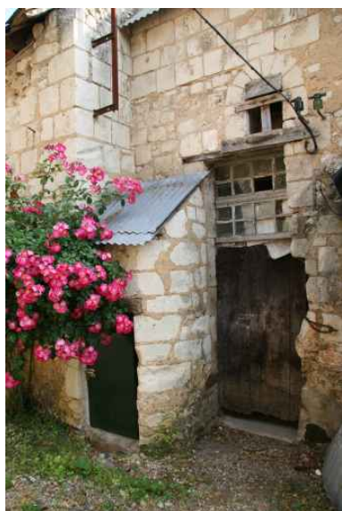
L'abside de la chapelle : petite baie plein cintre obstruée. Phot. Jean-Baptiste Darrasse IVR52_20067206010NUCA
