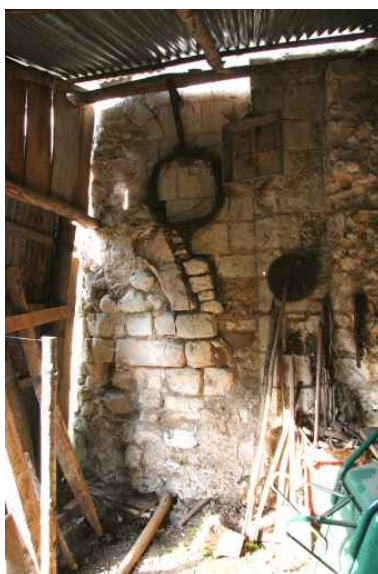
Mur gauche de l'abside : baie obstruée. Phot. Jean-Baptiste Darrasse IVR52_20067206018NUCA
