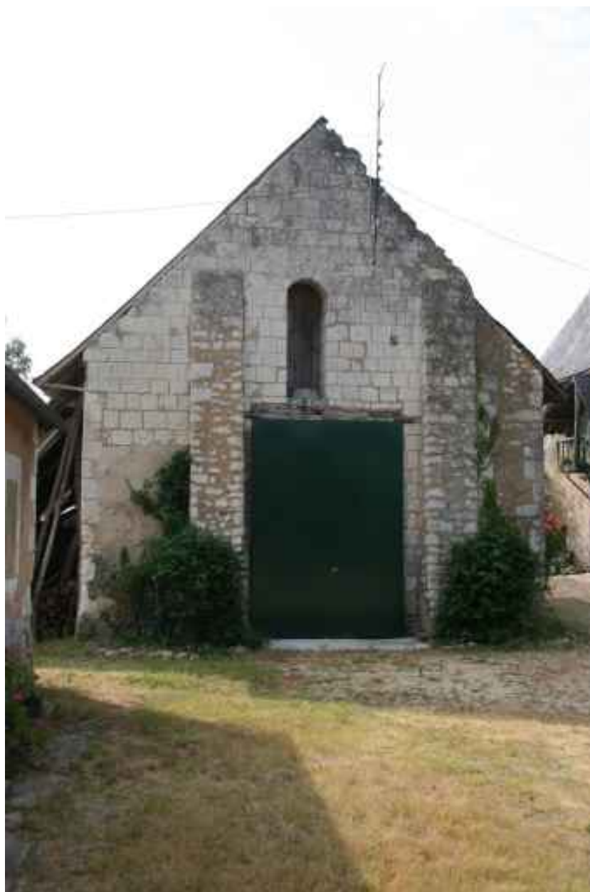
La chapelle : façade occidentale.
