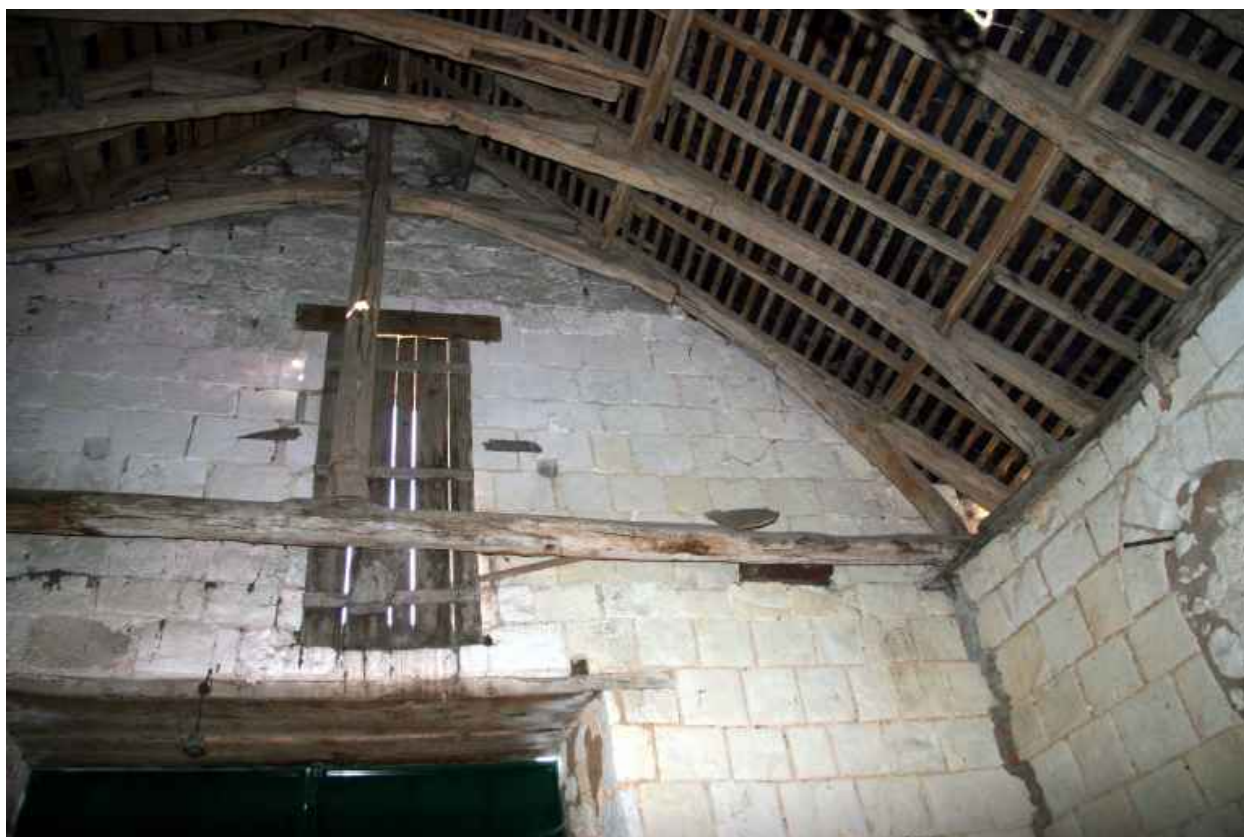
Charpente de la chapelle : ferme principale.
