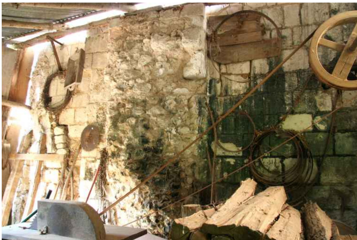
Mur gauche de la nef : baie en plein cintre obstruée.
