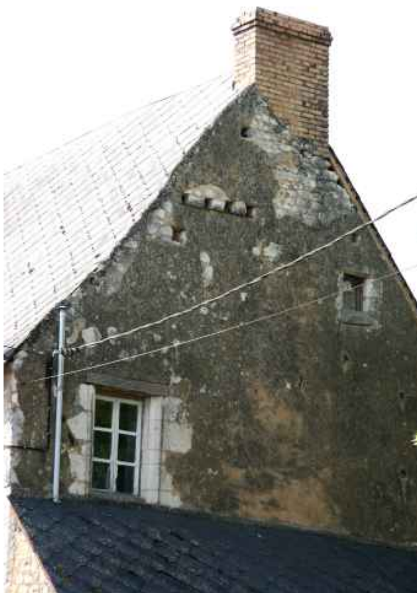
La maison du prieur : pignon.
