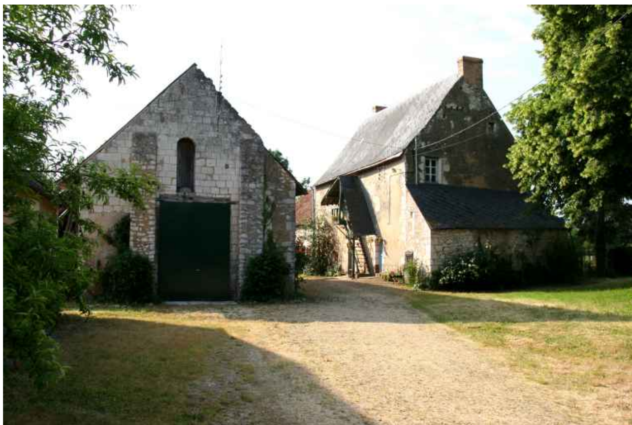
Vue d'ensemble de la chapelle et de la maison du prieur.
