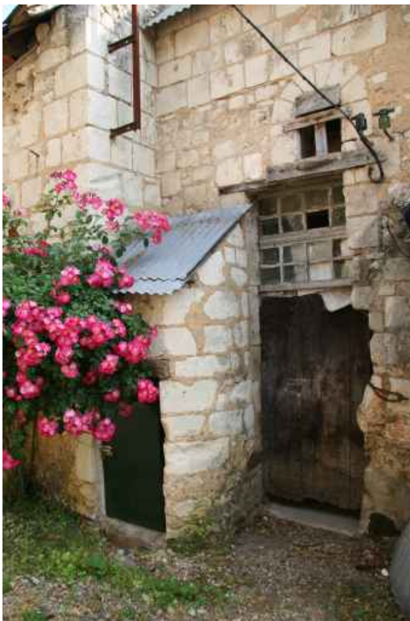
L'abside de la chapelle : petite baie plein cintre obstruée.
