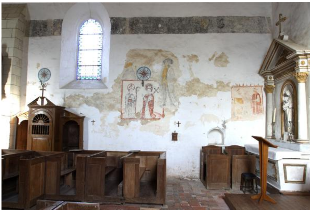
Nef, mur nord, partie orientale : vue d'ensemble des décors peints appartenant à plusieurs campagnes picturales.
