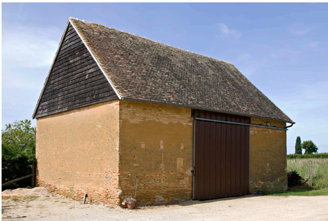
Grange de la ferme III
