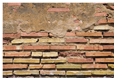
Détail du gros-œuvre de la grange Phot. Yves Guillotin IVR52_20117200673NUCA
