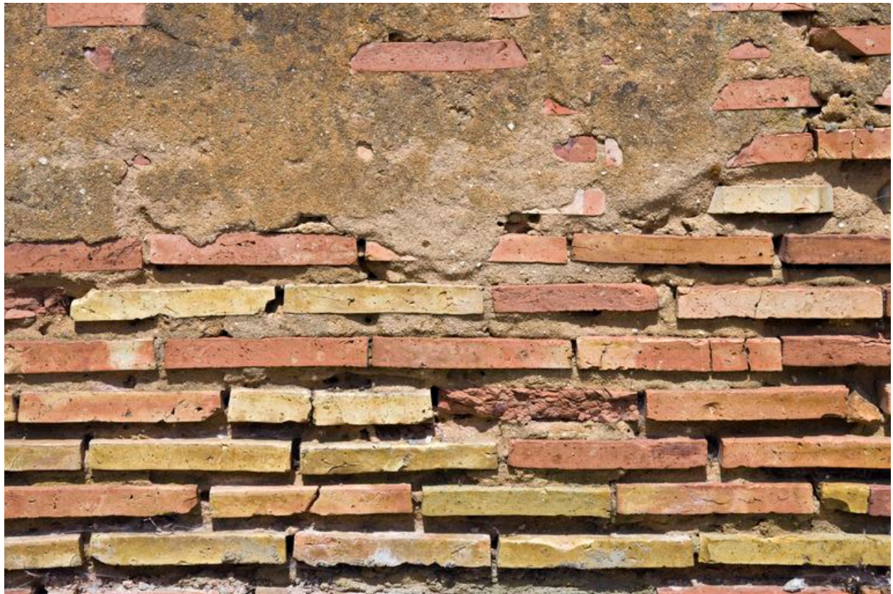
Détail du gros-œuvre de la grange
