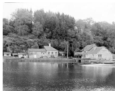
Vue d'ensemble du site du moulin depuis la rive droite en amont : ancien toit à porcs (transformé), ancienne étable à chevaux, anciens logis, anciens moulins à tan et à farine. Phot. François Lasa IVR52_20025300526X
