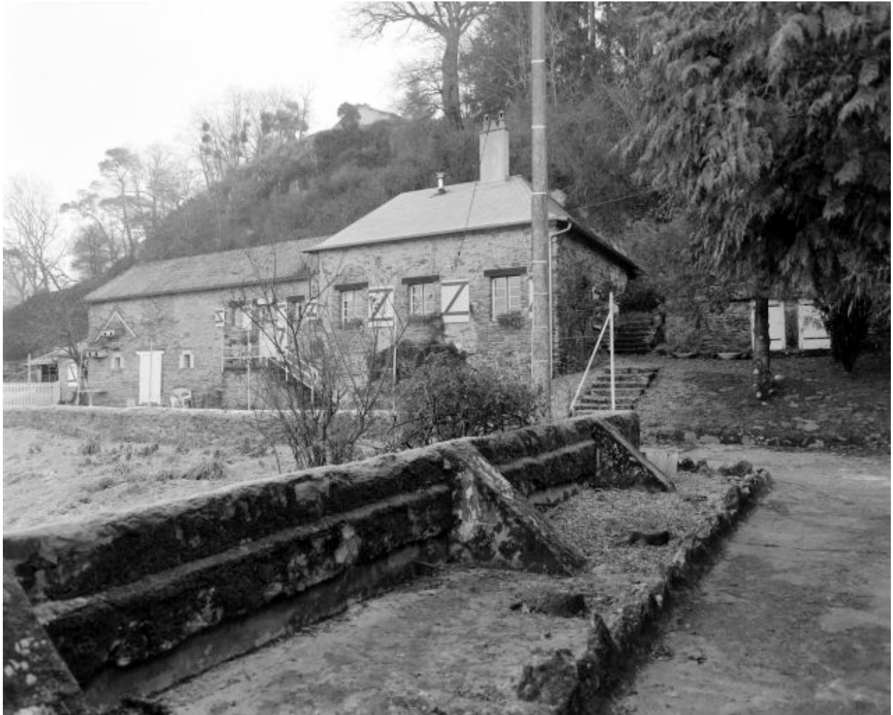
La dépendance principale. De gauche à droite : ancien toit à porcs, ancienne étable à chevaux, ancien logis. Détaché à droite, l'ancien poulailler.
