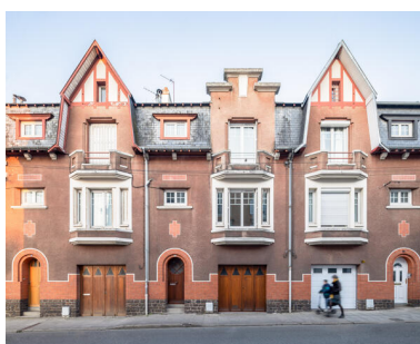
Vue des façades sur rue. Phot. Paul Hamelin IVR52_20227200908NUCA
