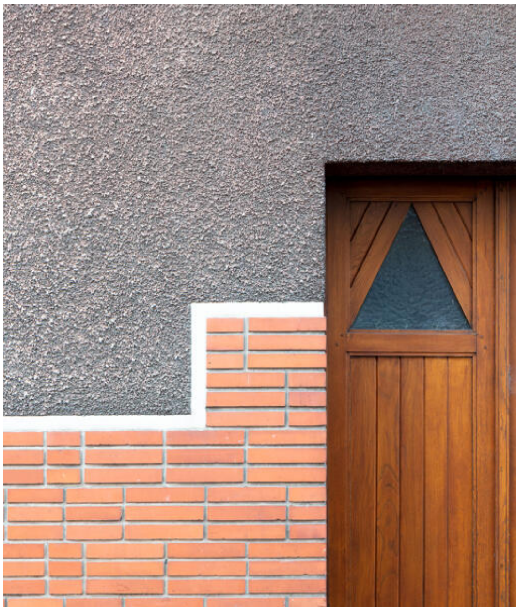
Détail des lignes et des matériaux en façade.
