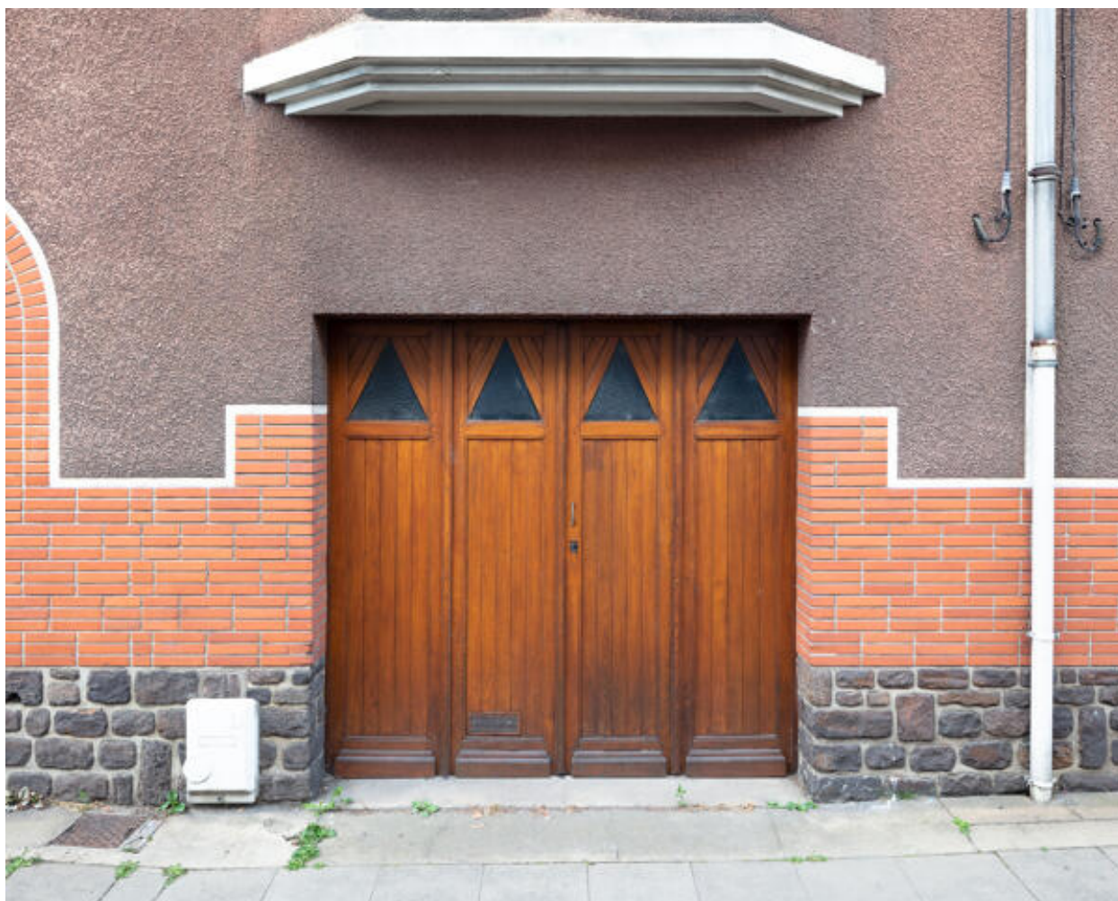
Vue d'une des portes de garage.
