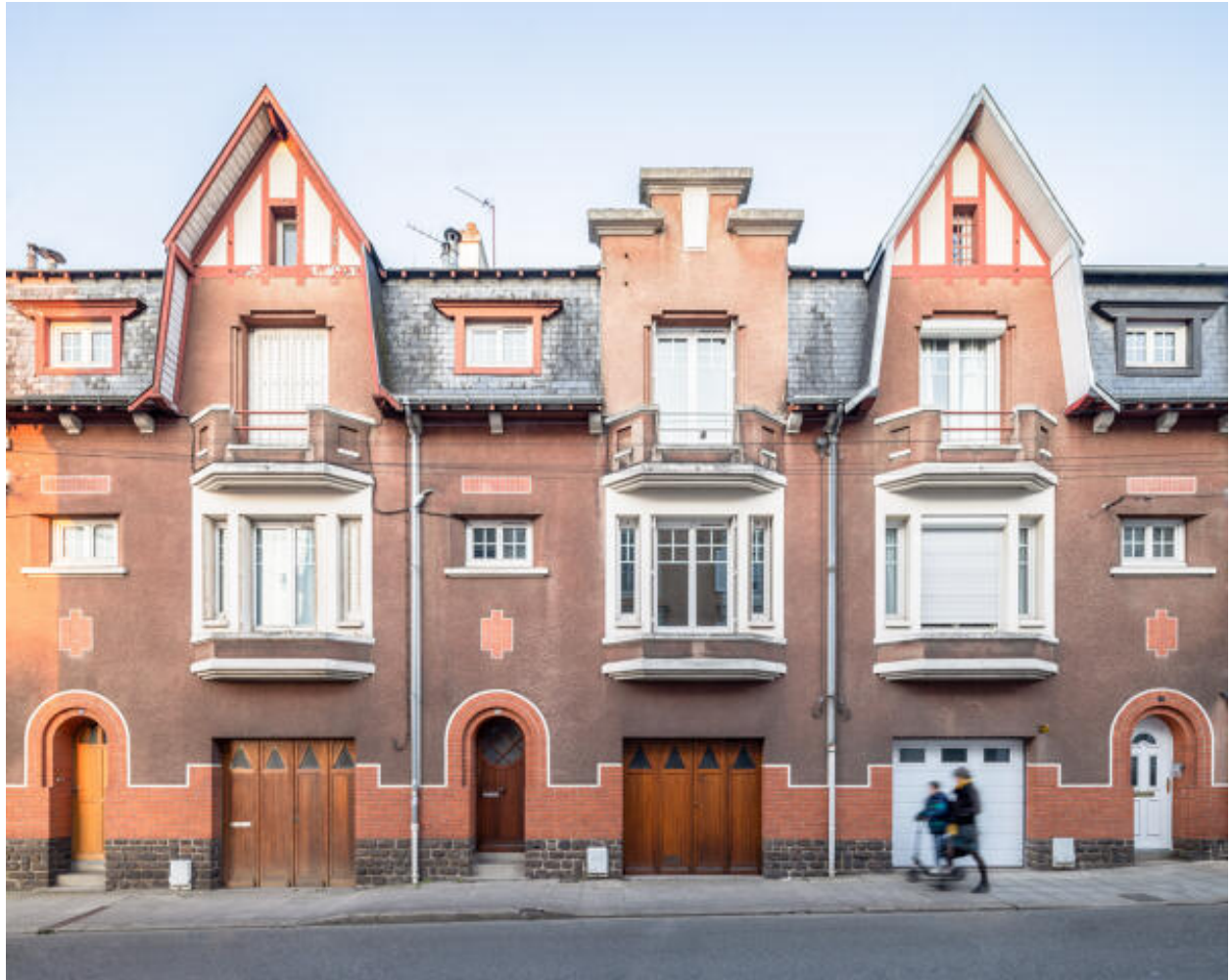
Vue des façades sur rue.
