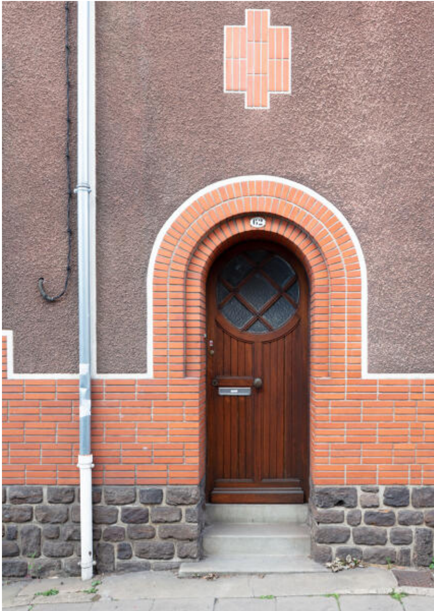
Vue d'une des portes d'entrée.
