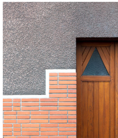
Détail des lignes et des matériaux en façade. Phot. Paul Hamelin IVR52_20227200854NUCA
