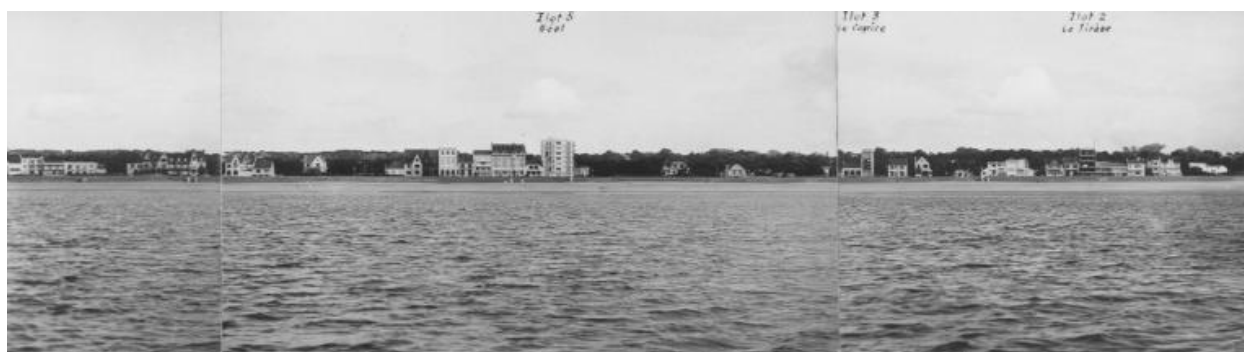
Front de mer boulevard de l'Océan.
