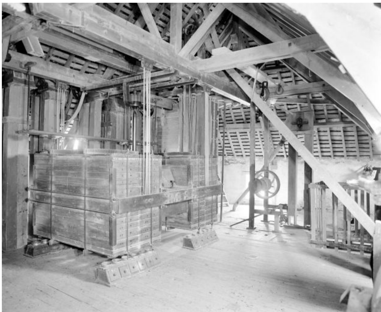
Comble du moulin. Le plansichter.
