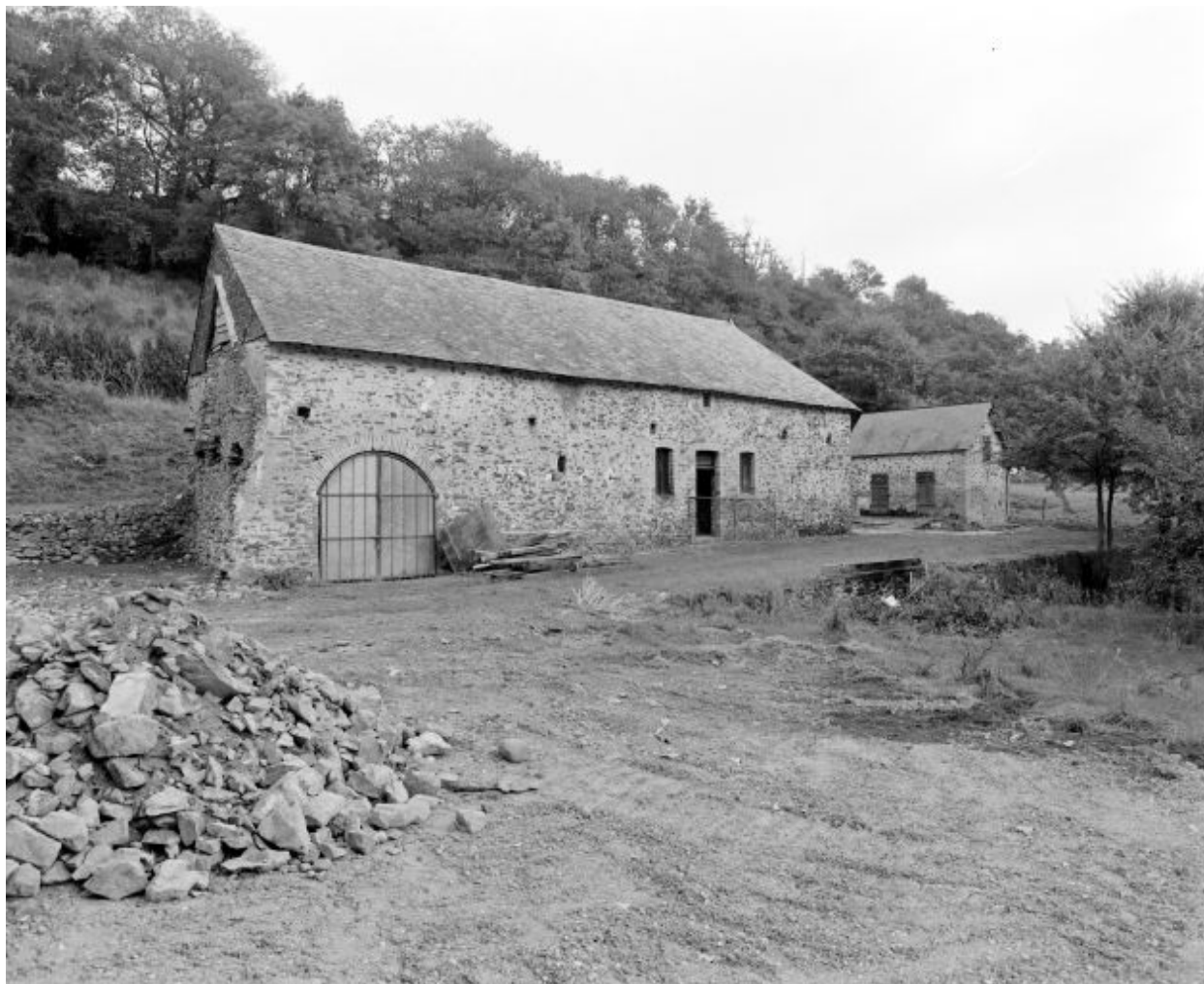
Le bâtiment de dépendances et la porcherie, vus de l'ouest. A gauche, arrachements de l'ancienne maison, devenue remise.
