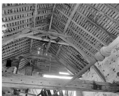
La charpente du vieux moulin. Au premier plan, l'axe horizontal qui reliait l'axe moteur vertical de la turbine aux meules situées au premier étage du moulin dit de la filature. Phot. François Lasa IVR52_20015300606X
