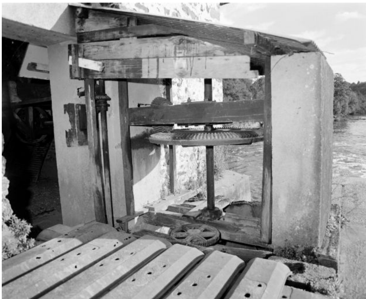
Le système de transmission de la force de la turbine, situé contre le mur ouest du vieux moulin.
