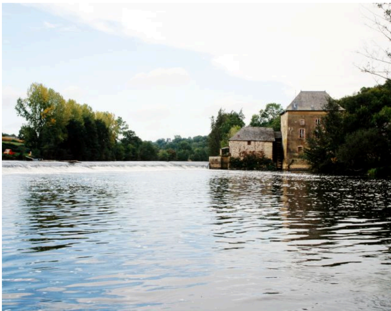
Vue du moulin depuis la rive gauche en aval : façades sud.
