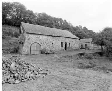
Le bâtiment de dépendances et la porcherie, vus de l'ouest. A gauche, arrachements de l'ancienne maison, devenue remise. Phot. François Lasa IVR52_20015300594X
