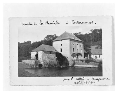
Vue d'aval pendant les travaux d'installation de la turbine et de réaménagement du vieux moulin.
