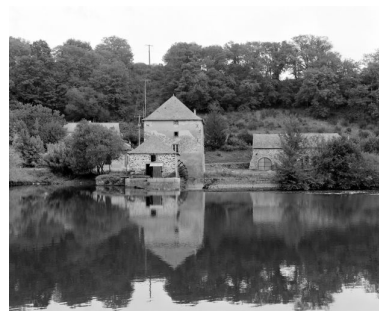
Vue de face du moulin depuis la rive droite : façades ouest de la maison et du moulin, emplacement de l'ancienne maison (détruite) et dans son prolongement, dépendance. Phot. François Lasa IVR52_20015300587X
