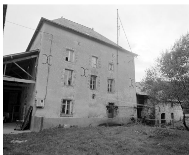
Façade nord du vieux moulin et du moulin dit de la filature. Phot. François Lasa IVR52_20015300595X
