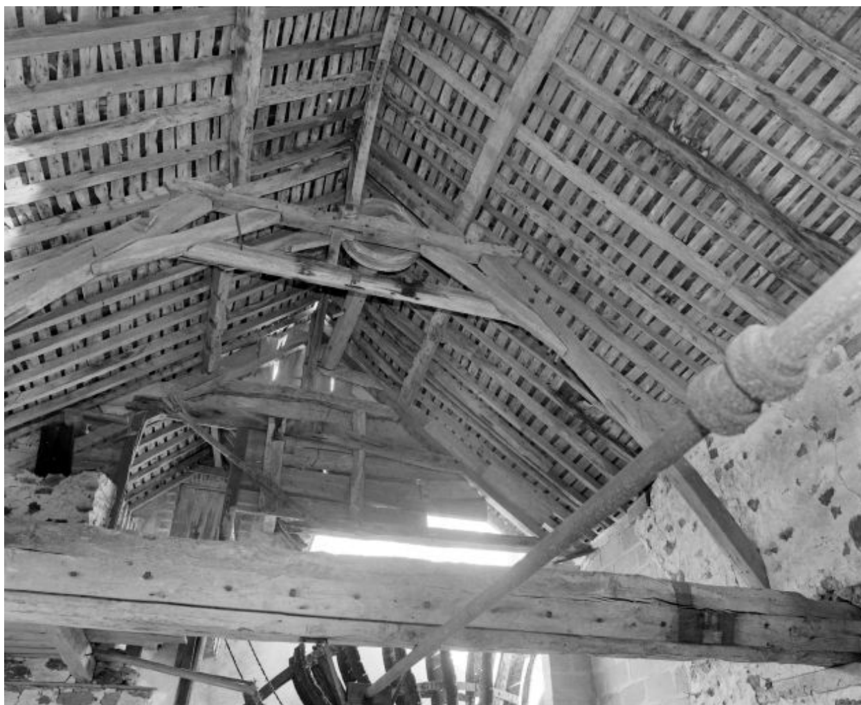
La charpente du vieux moulin. Au premier plan, l'axe horizontal qui reliait l'axe moteur vertical de la turbine aux meules situées au premier étage du moulin dit de la filature.
