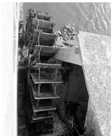
La roue vue du deuxième étage du moulin dit de la filature. Phot. François Lasa IVR52_20015300603X
