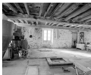
Le premier étage du moulin, vu vers l'ouest. A gauche, machine à séparer le grain de l'écorce. Au premier plan, trace au sol des machines à cylindres. Au fond, emplacement des deux meules. Phot. François Lasa IVR52_20015300601X
