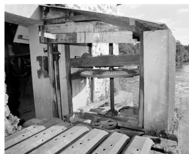
Le système de transmission de la force de la turbine, situé contre le mur ouest du vieux moulin. Phot. François Lasa IVR52_20015300607X
