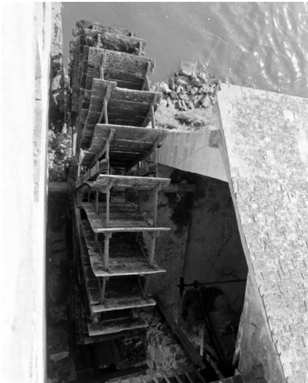
La roue vue du deuxième étage du moulin dit de la filature.
