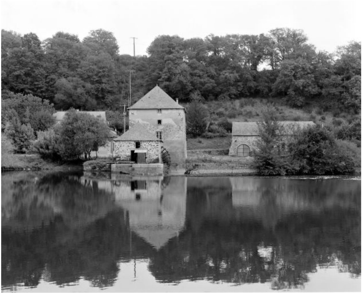
Vue de face du moulin depuis la rive droite : façades ouest de la maison et du moulin, emplacement de l'ancienne maison (détruite) et dans son prolongement, dépendance.
