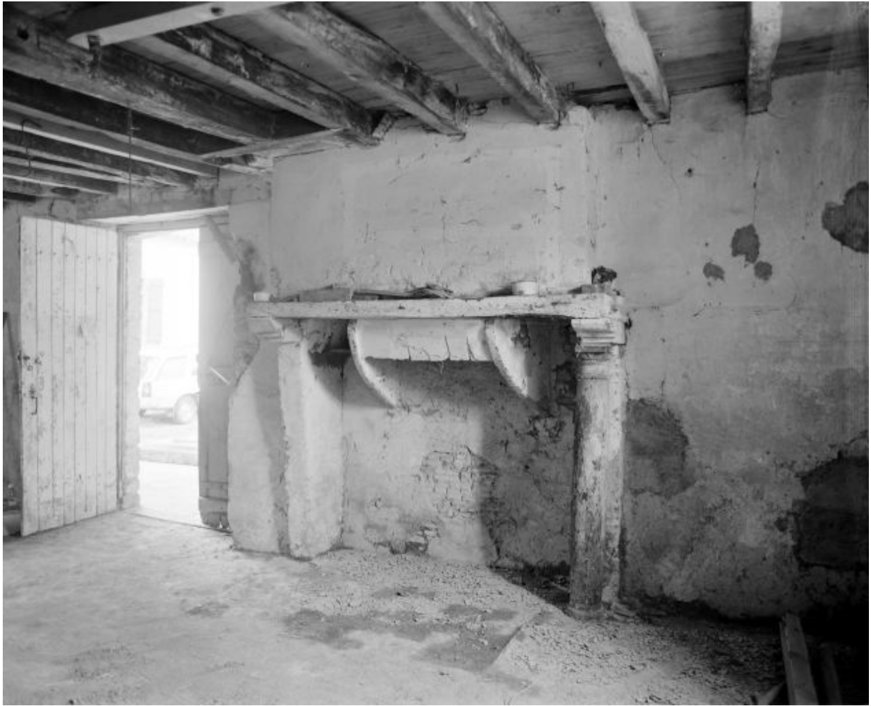
Cheminée placée contre le mur est du rez-de-chaussée du moulin.
