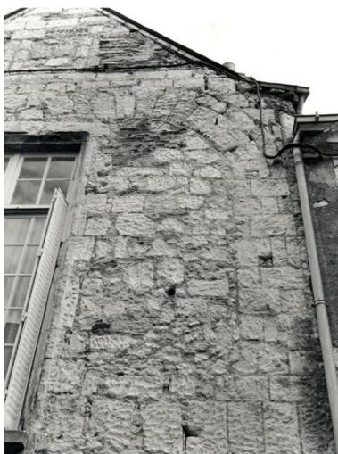
Logis principal 12e s., aile droite, élévation sur rue, 1er étage, partie droite : vestiges d'une baie géminée en plein-cintre et d'une colonnette d'angle engagée.
