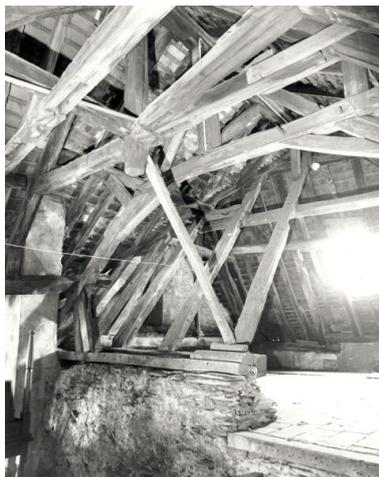
Jonction du logis sud-ouest (B) et de l'aile droite (A2) du logis principal 12e s., à hauteur des combles. Au 1er plan, la ferme de tête gauche de l'aile droite.
