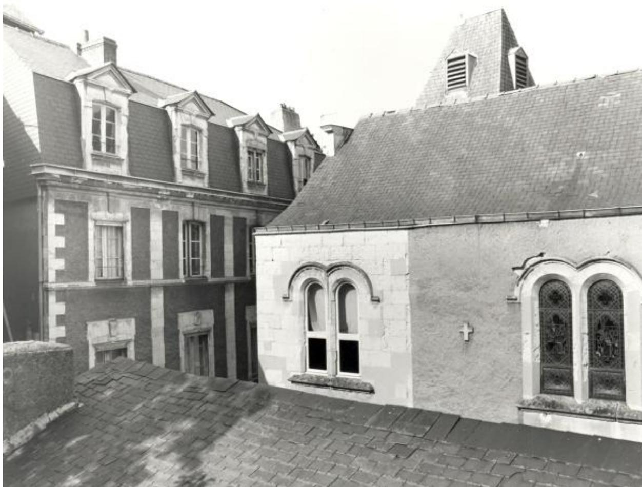
Façade sur cour du logis 19e s. à gauche, et au centre et à droite, extension 19e s. (élévation en tuffeau) du corps principal en schiste enduit du logis 12e s. (actuelle chapelle).
