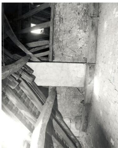
Logis principal 12e s., aile droite, élévation latérale droite, partie gauche et supérieure du premier étage : vestiges de l'arc en plein-cintre
