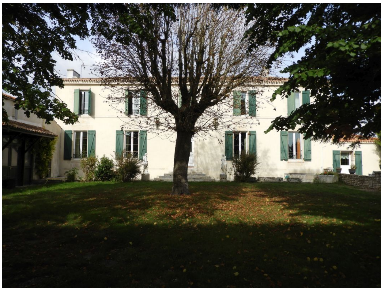
Le logis vu depuis le sud.
