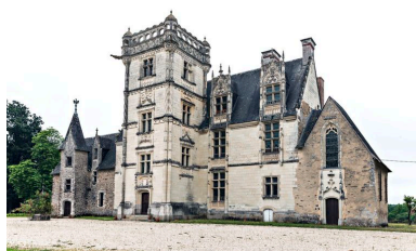
Elévation principale du château. Phot. Yves Guillotin IVR52_20155300269NUCA
