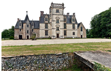
Elévation principale du château. Phot. Yves Guillotin IVR52_20155300270NUCA
