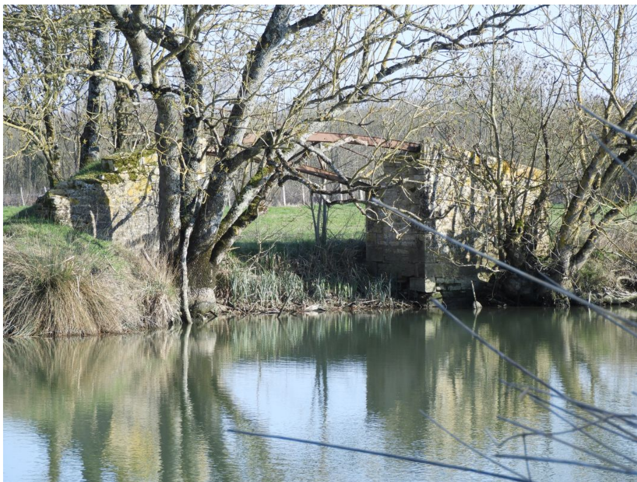
La passerelle vue depuis l'ouest.
