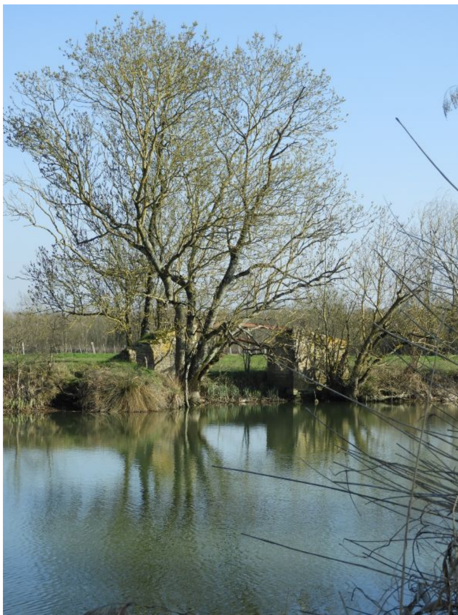
La passerelle vue depuis l'ouest.
