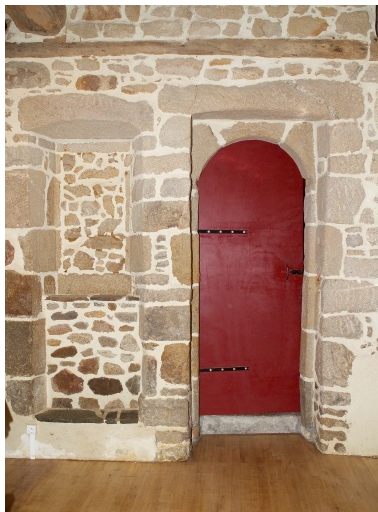
Parement interne de la façade arrière. Phot. Denis Pillet IVR52_20074400882NUCA
