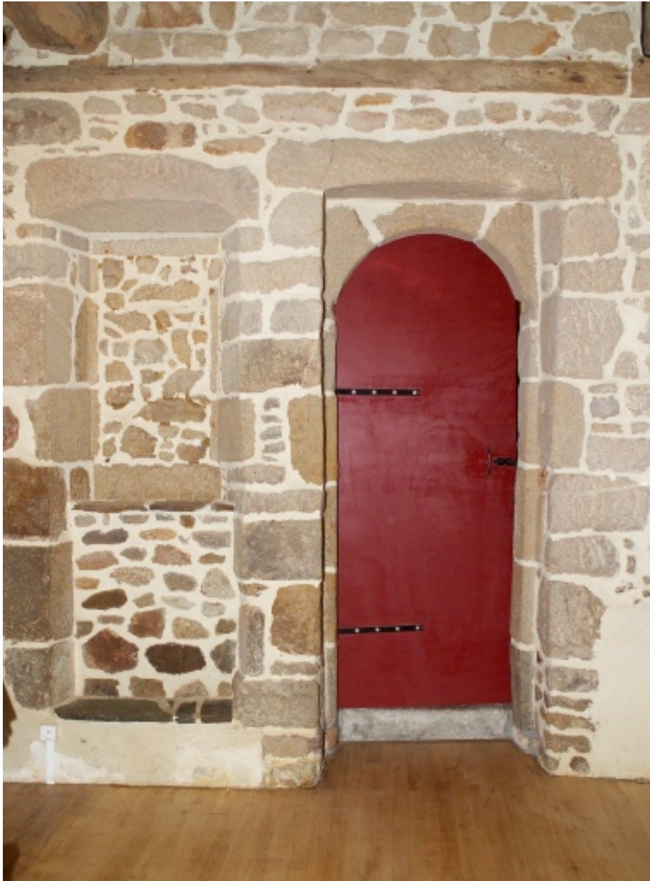
Parement interne de la façade arrière.
