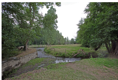
Le barrage sur la Mayenne, le canal d'alimentation du moulin et l'embouchure du ruisseau de Lassay vus depuis le moulin au sud-ouest. Phot. François Lasa IVR52_20065300738NUCA
