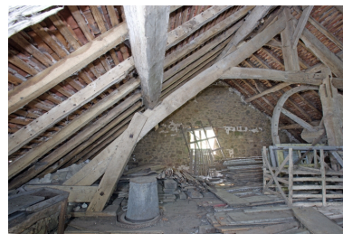
Le moulin à farine sur la Mayenne : le comble vu depuis le nord. Phot. François Lasa IVR52_20065300736NUCA
