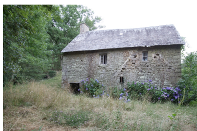
Le moulin à foulon : élévation nord. Phot. François Lasa IVR52_20065300755NUCA
