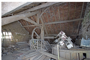
Le moulin à farine sur la Mayenne : le comble vu depuis le nord-est. Au premier plan, les meules dans leurs archures. Phot. François Lasa IVR52_20065300737NUCA
