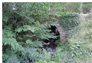
Le pont sur le ruisseau de Lassay, vu depuis le nord. Phot. François Lasa IVR52_20065300754NUCA
