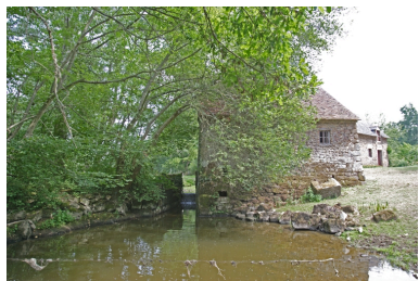
Le moulin à farine sur la Mayenne : élévation ouest. A droite, l'étable. Phot. François Lasa IVR52_20065300727NUCA
