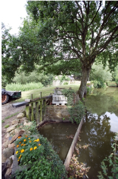
Vanne d'alimentation du moulin à farine sur la chaussée de l'étang de retenue. Phot. François Lasa IVR52_20065300747NUCA
