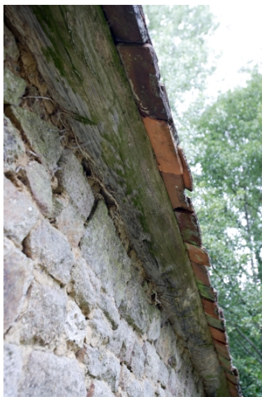
Le moulin à farine sur la Mayenne, élévation est : détail de la sablière. Phot. François Lasa IVR52_20065300739NUCA
