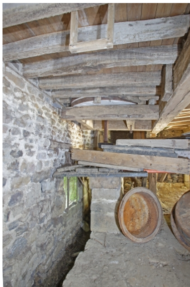
Le moulin à farine sur la Mayenne, rez-de-chaussée : emplacement du rouet de fosse (disparu), pignon de renvoi et meules. Phot. François Lasa IVR52_20065300734NUCA
