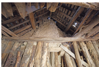
La buanderie ou logement, actuellement bergerie : la cloison et le conduit de cheminée vus depuis le sud. Phot. François Lasa IVR52_20065300752NUCA
