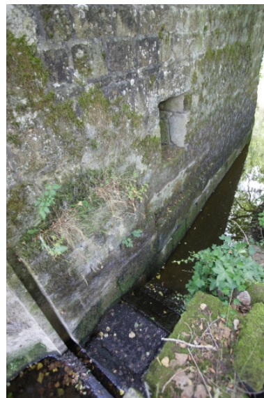
Le moulin à farine sur la Mayenne : emplacement de la roue. Phot. François Lasa IVR52_20065300731NUCA
