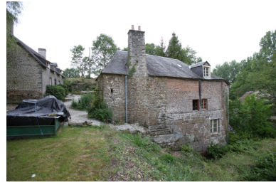
Le moulin à farine sur le ruisseau : élévation est avec la chute d'eau. A gauche, la maison. Phot. François Lasa IVR52_20065300744NUCA
