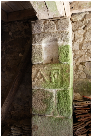
Le moulin à farine sur la Mayenne, rez-de-chaussée : inscription sur le poteau est. Phot. François Lasa IVR52_20065300733NUCA
