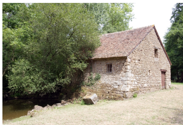
Le moulin à farine sur la Mayenne : élévations ouest et sud. Phot. François Lasa IVR52_20065300726NUCA
