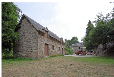
L'étable et le moulin à farine sur le ruisseau vus depuis le nord-ouest. Phot. François Lasa IVR52_20065300732NUCA
