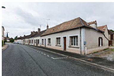
Vue du village depuis l'est. Phot. Yves Guillotin IVR52_20177200769NUCA
