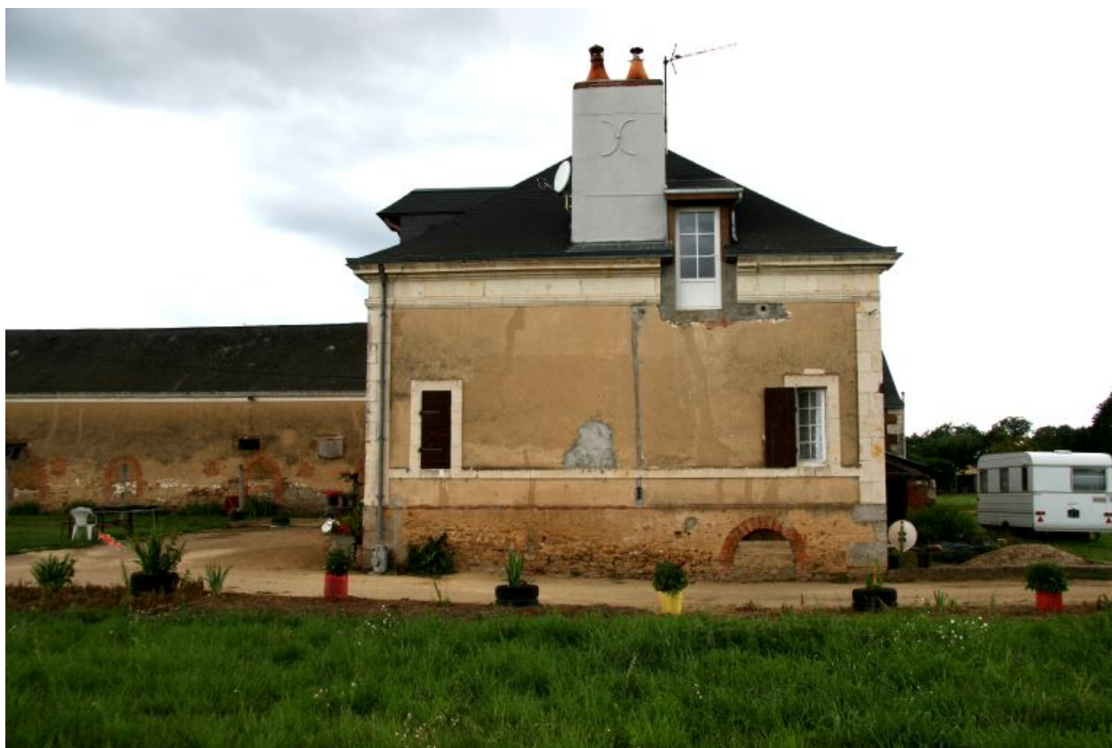
La maison : pignon.
