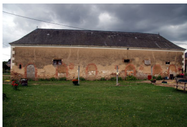
Les dépendances : orientation inversée. Phot. Jean-Baptiste Darrasse IVR52_20057202684NUCA
