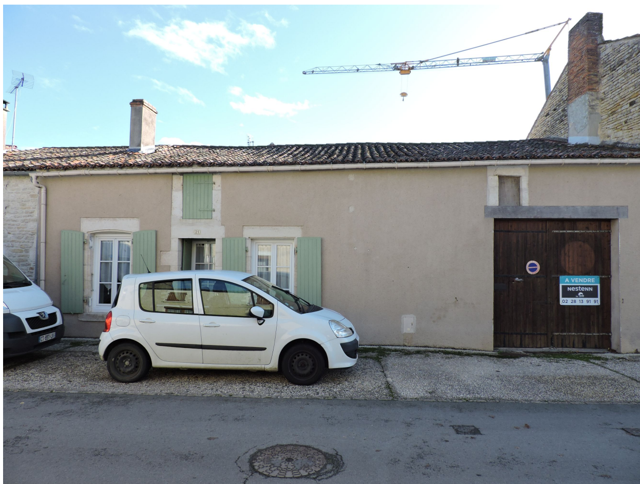
Vue depuis le nord.
