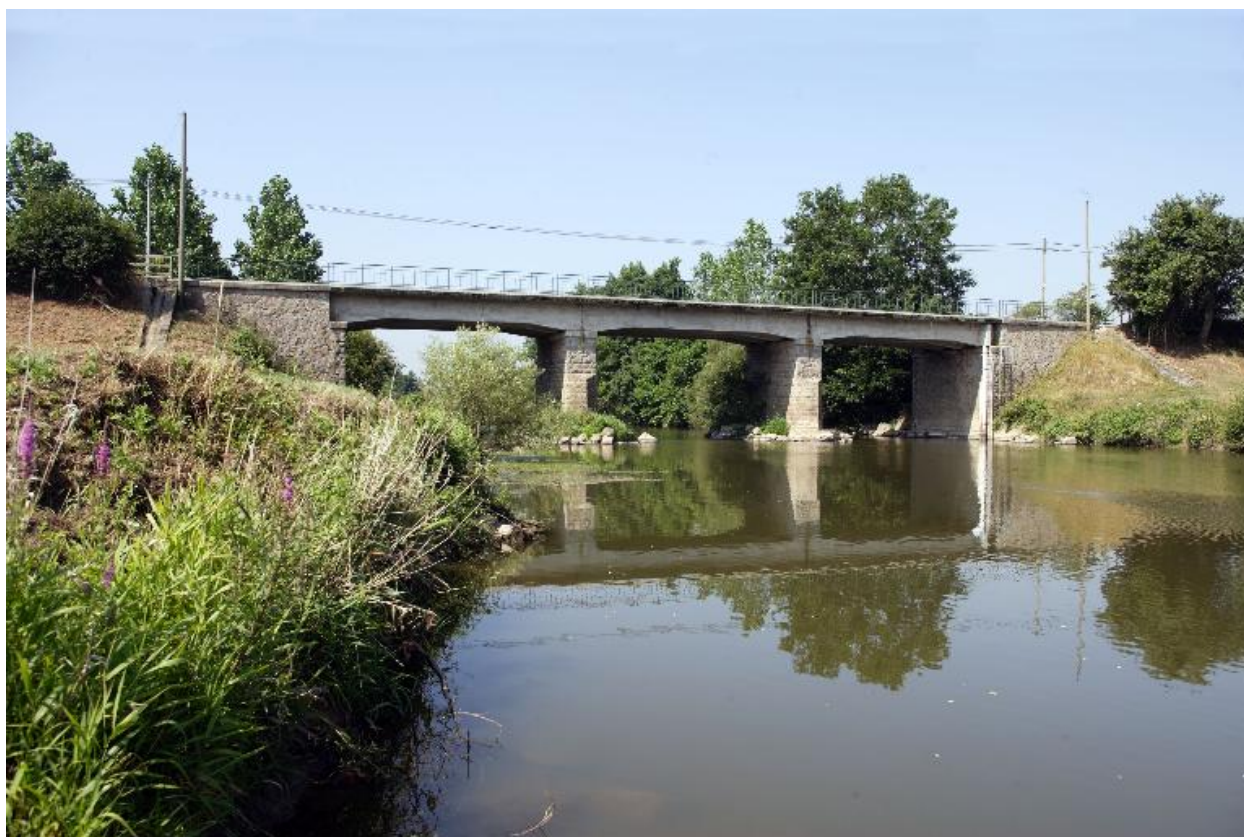
Vue depuis l'aval.
