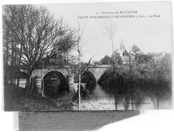
Vue depuis l'aval du pont détruit pendant la 2e Guerre mondiale. Autr. V. Carré, Autr. E. Chouasnet, Repro. François Lasa IVR52_20015300382X
