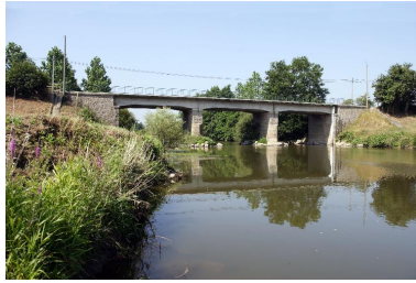
Vue depuis l'aval. Phot. François Lasa IVR52_20055300378NUCA
