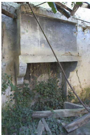
La cheminée. Phot. François Lasa IVR52_20045302513NUCA
