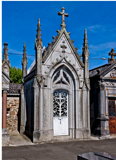
Vue d'ensemble de la chapelle. Phot. Yves Guillotin IVR52_20155300058NUCA
