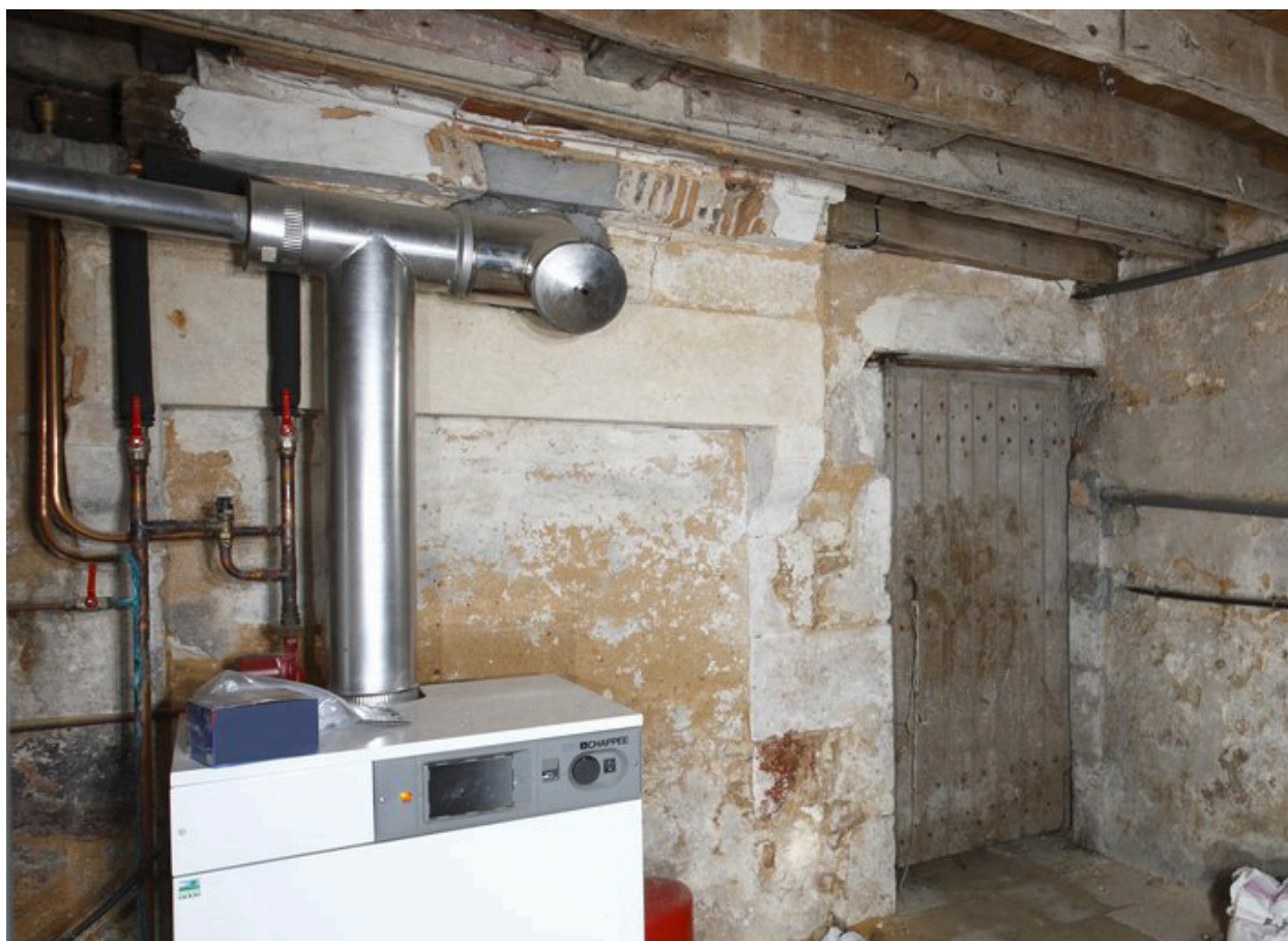
Sous-sol de la maison : cheminée de la cuisine basse et porte du cellier.
