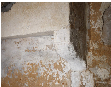
Sous-sol de la maison : détail de la cheminée de la cuisine basse.
