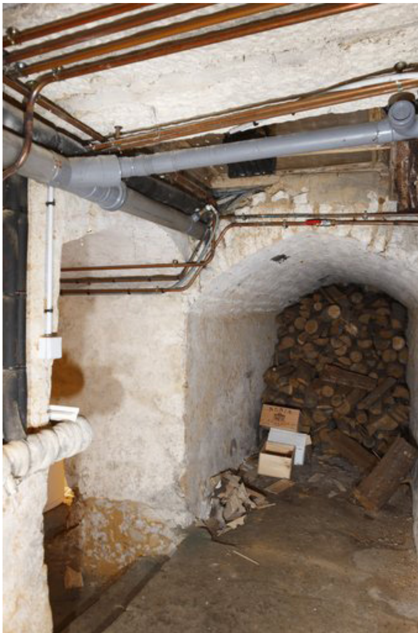
Sous-sol de la maison : accès à la seconde cave et caveau.
