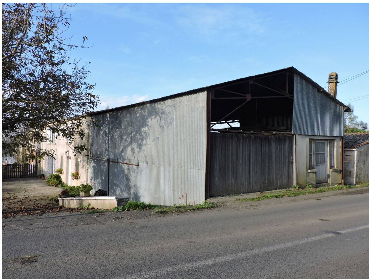
Le hangar métallique vu depuis le sud-est.
