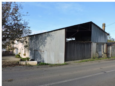
Le hangar métallique vu depuis le sud-est. Phot. Yannis Suire IVR52_20218500755NUCA
