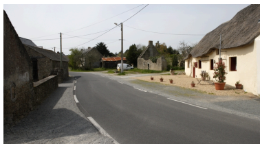
Vue d'ensemble de la rangée depuis l'est. Phot. Denis Pillet IVR52_20084401516NUCA
