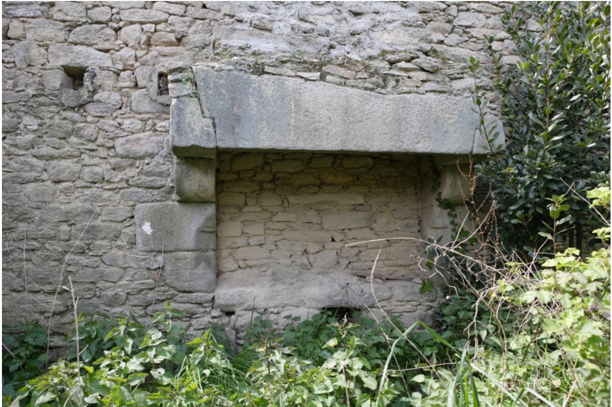
Détail de la cheminée du premier logis.
