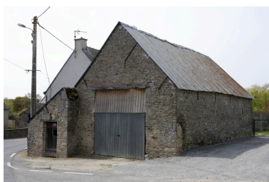
Vue de la remise au bout de la rangée. Phot. Denis Pillet IVR52_20084401517NUCA
