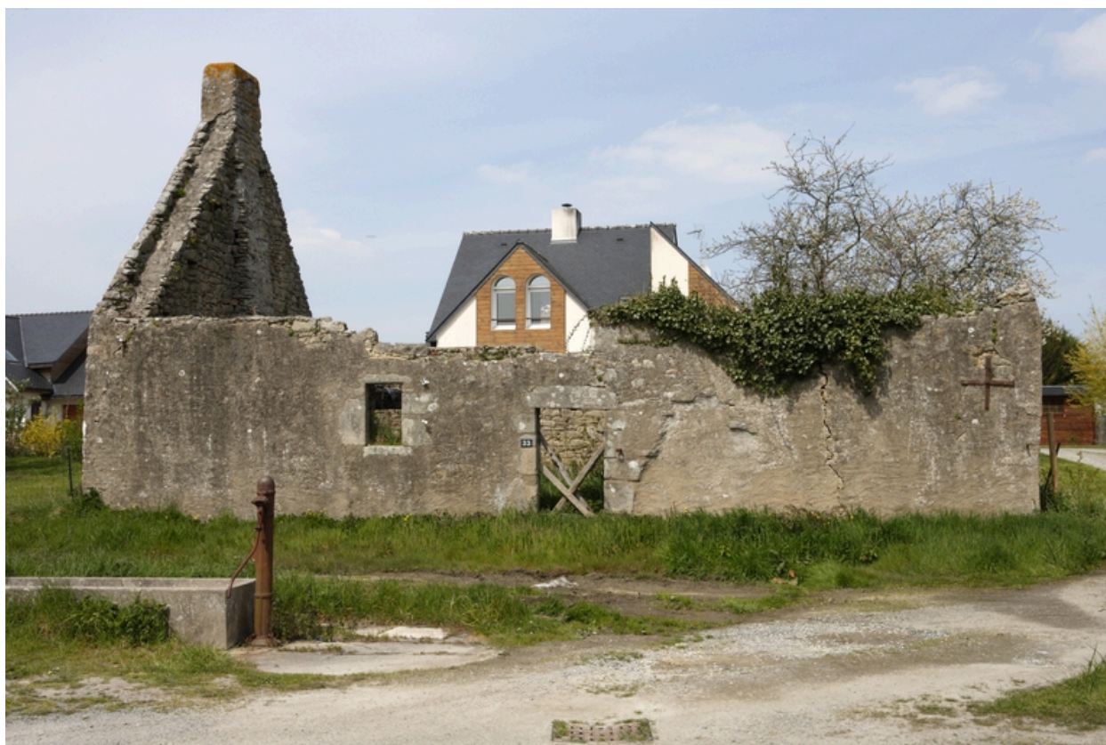
Vue du premier logis.
