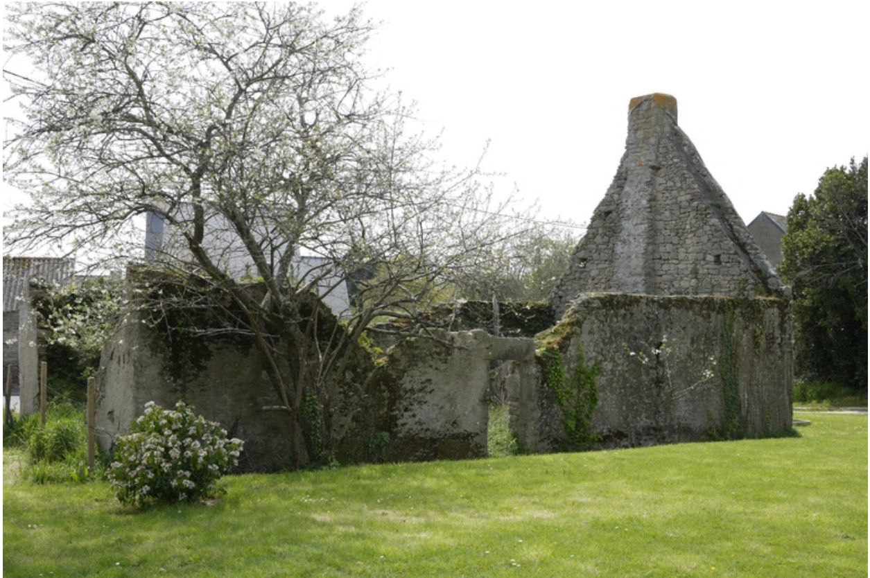
Vue de la façade arrière du premier logis.
