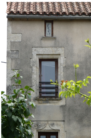
Travée d'ouvertures avec appuis moulurés et linteau en accolade, sur le côté ouest de la maison. Phot. Yannis Suire IVR52_20238501370NUCA
