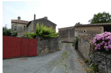
La maison, à gauche, et la ruelle qui la jouxte vues depuis le nord-ouest. Phot. Yannis Suire IVR52_20238501368NUCA
