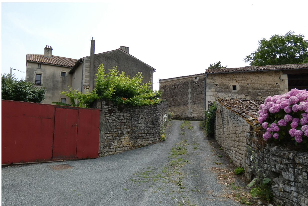
La maison, à gauche, et la ruelle qui la jouxte vues depuis le nord-ouest.
