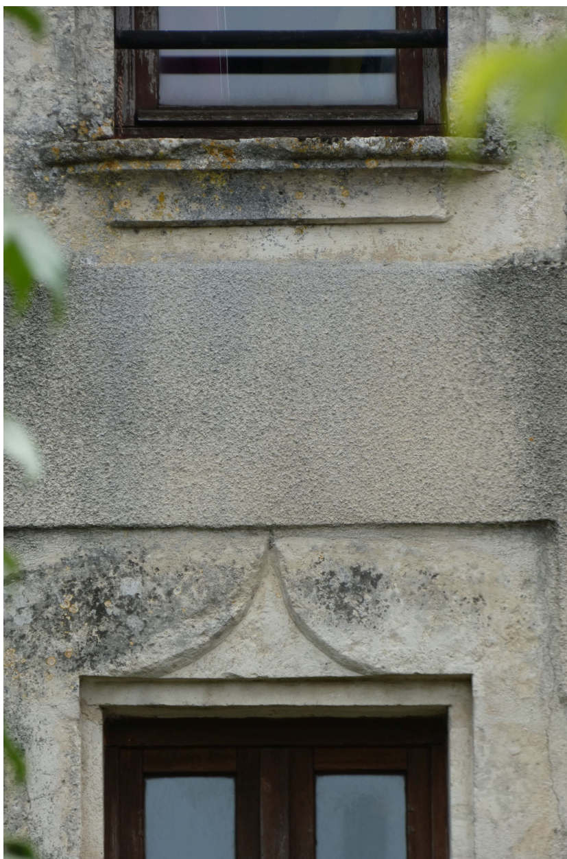
Appui mouluré et linteau en accolade.
