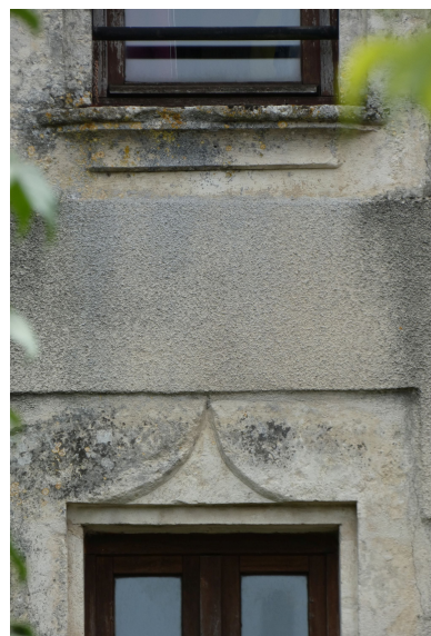
Appui mouluré et linteau en accolade. Phot. Yannis Suire IVR52_20238501371NUCA
