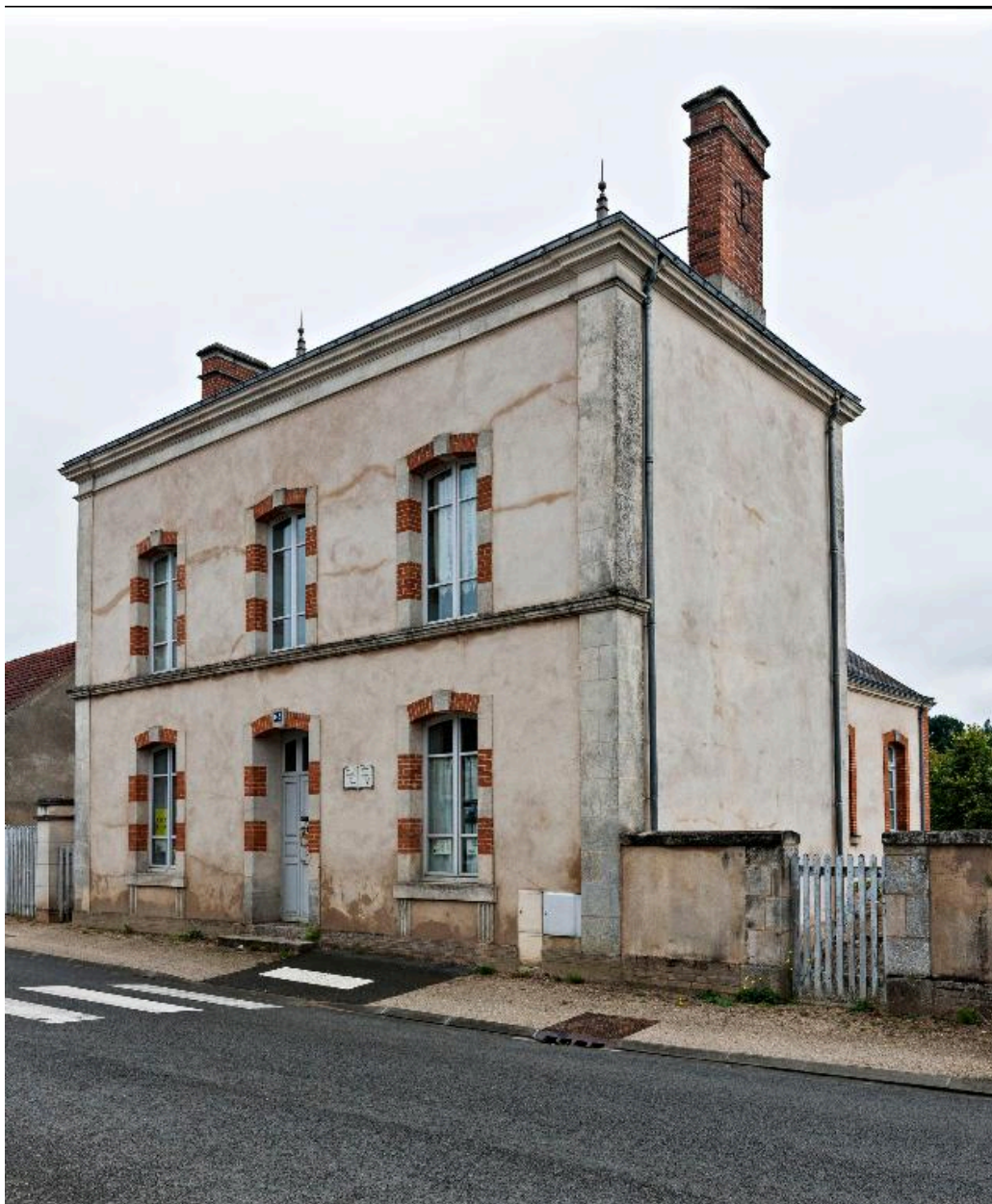
Elévation sur rue du corps principal. principal
