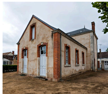
Le corps de bâtiment des classes.
