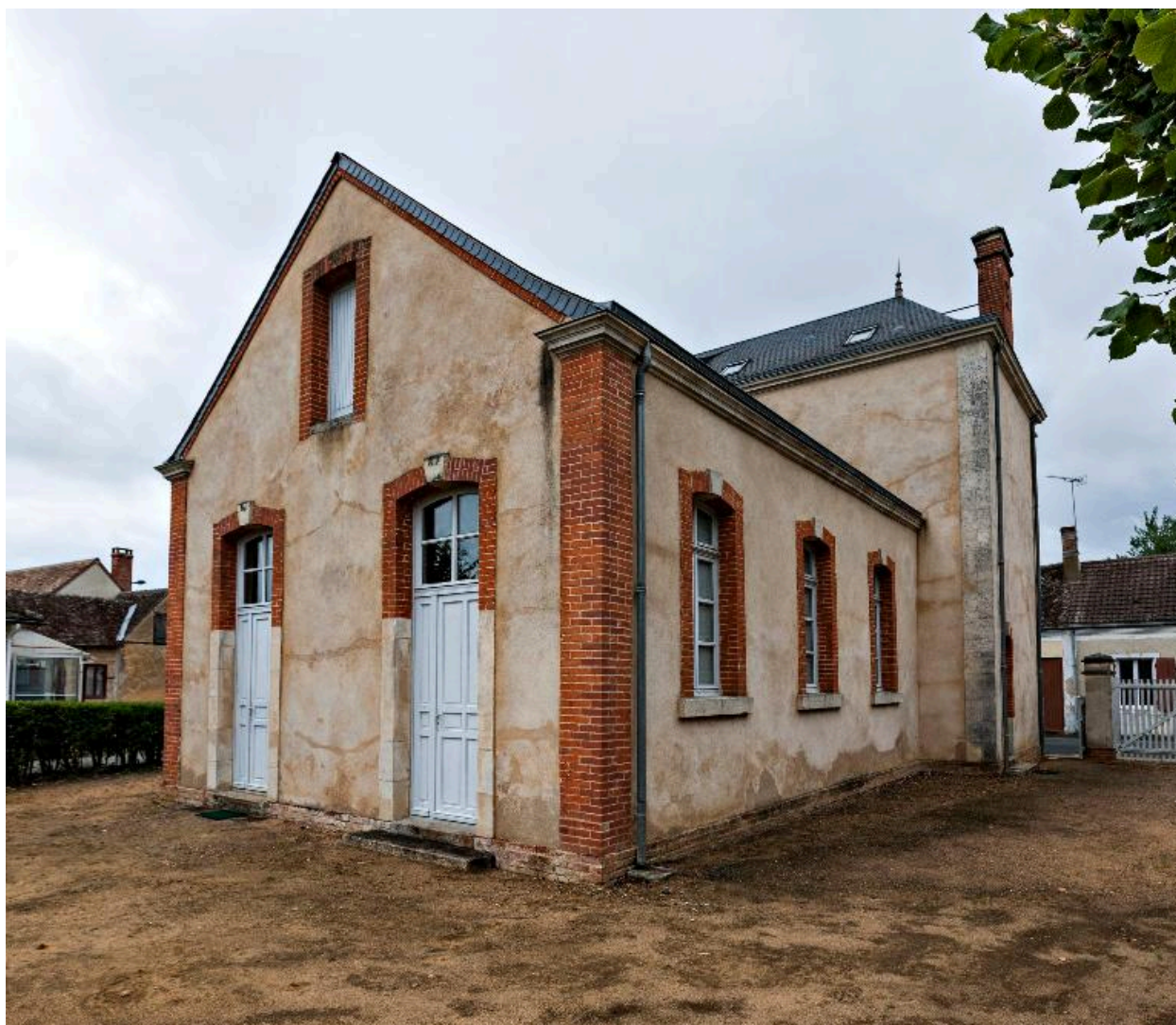
Le corps de bâtiment des classes.
