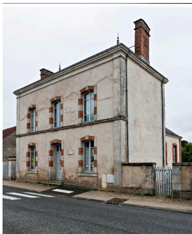
Elévation sur rue du corps principal. principal
