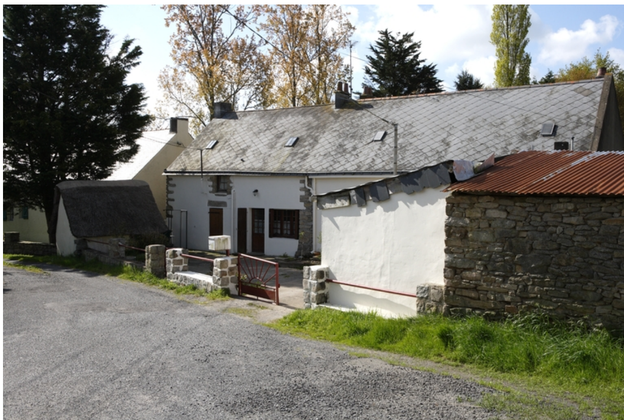
Vue de la rangée de ferme depuis le nord-ouest.
