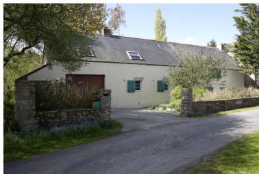
Vue de la rangée depuis le nord-est. Phot. Denis Pillet IVR52_20084401352NUCA
