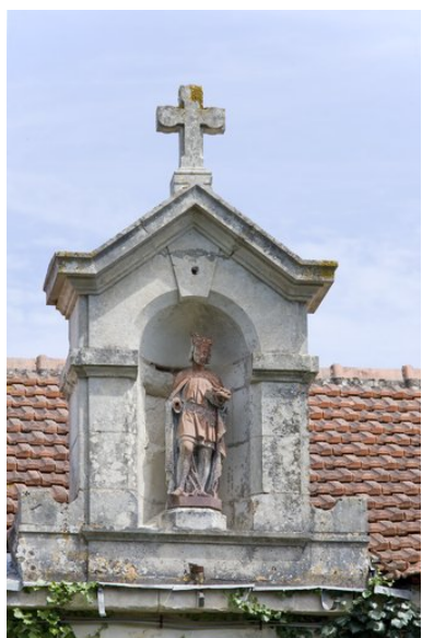
Niche contenant la statue de saint Louis, sur le bâtiment principal. Phot. Patrice Giraud IVR52_20108500364NUCA
