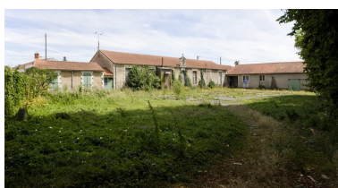
Vue d'ensemble prise du nord-ouest. Phot. Patrice Giraud IVR52_20108500365NUCA
