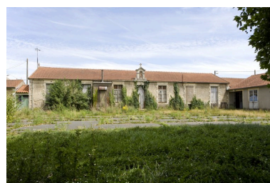
Vue du bâtiment principal, prise de l'ouest. Phot. Patrice Giraud IVR52_20108500363NUCA
