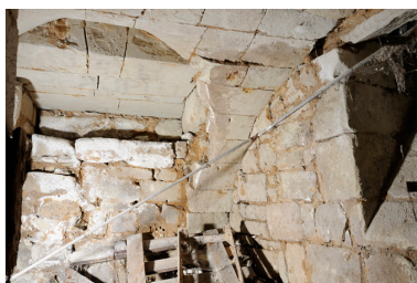
Premier sous-sol : ancien accès depuis la rue des Masques (à gauche, obturé), soupirail ouvrant sur la rue Robert d'Arbrissel (à droite). Phot. Bruno Rousseau, Phot. Youenn Communeau IVR52_20114902221NUCA
