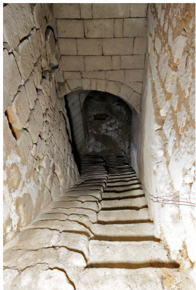
Descente du premier au second sous-sol : partie haute. Phot. Bruno Rousseau, Phot. Youenn Communeau IVR52_20114902220NUCA
