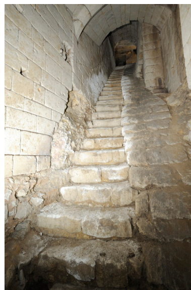
Descente du premier au second sous-sol : escalier droit et rampe. Phot. Bruno Rousseau, Phot. Youenn Communeau IVR52_20114902191NUCA
