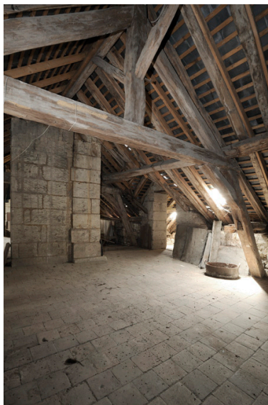
Charpente et comble du corps sur la rue des Masques. Phot. Bruno Rousseau, Phot. Youenn Communeau IVR52_20114902196NUCA
