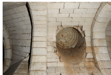
Voûte du palier du second sous-sol : détail du conduit circulaire, obturé. Phot. Bruno Rousseau, Phot. Youenn Communeau IVR52_20114902212NUCA
