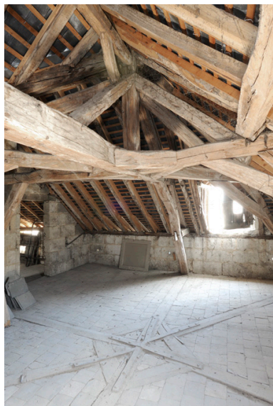
Charpente et comble du corps à l'angle des rues des Masques et Robert d'Arbrissel : enrayures des entrails et faux-entrails, en regard. Phot. Bruno Rousseau, Phot. Youenn Communeau IVR52_20114902195NUCA
