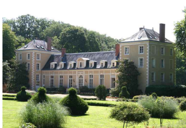
Vue de volume prise depuis l'entrée. Phot. Jean-Baptiste Darrasse IVR52_20057203316NUCA
