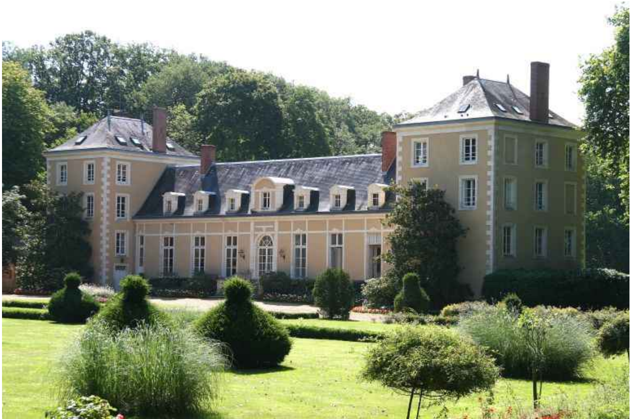
Vue de volume prise depuis l'entrée.
