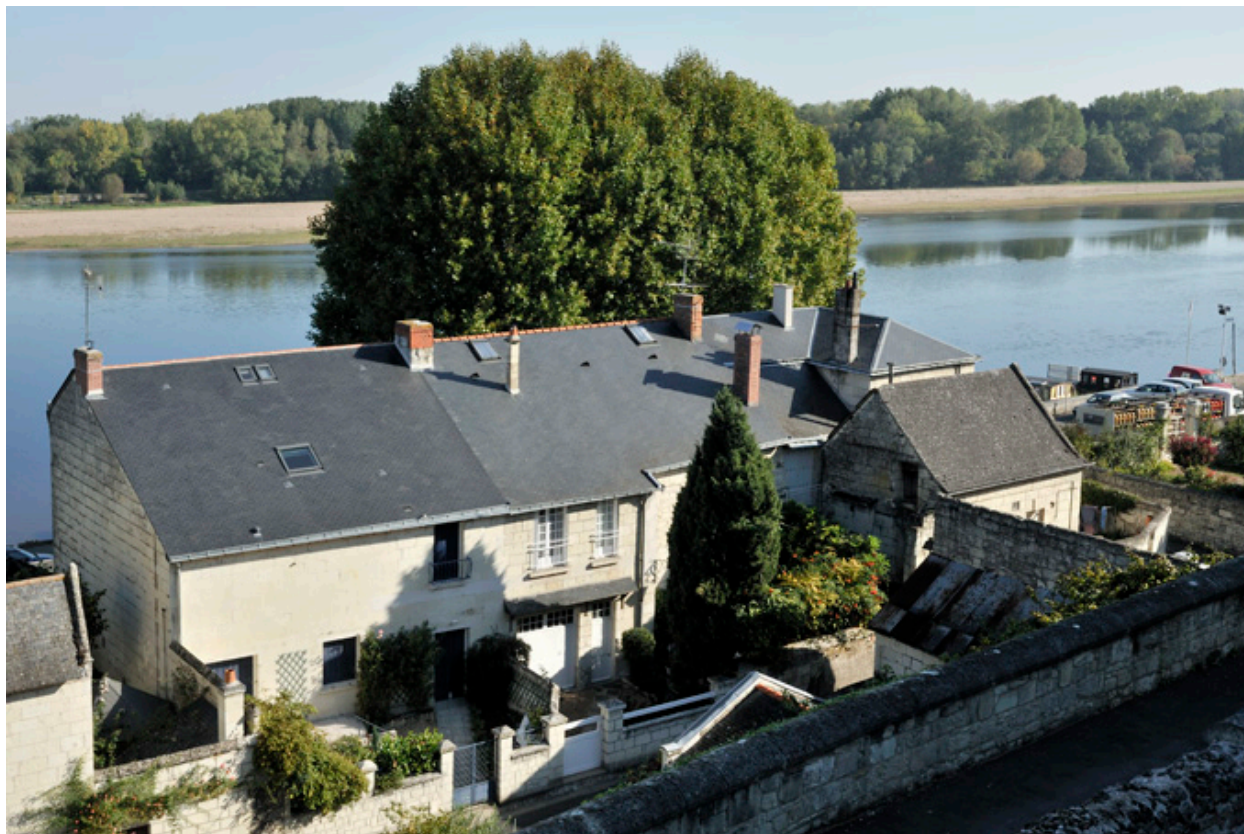
Façades postérieures, vue d'ensemble depuis le haut du coteau.
