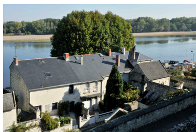
Façades postérieures, vue d'ensemble depuis le haut du coteau. Phot. Bruno Rousseau, Phot. Youenn Communeau IVR52_20114902632NUCA
