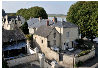
Vue des façades postérieures de l'îlot, depuis la Haute rue. Phot. Bruno Rousseau, Phot. Youenn Communeau IVR52_20114902623NUCA
